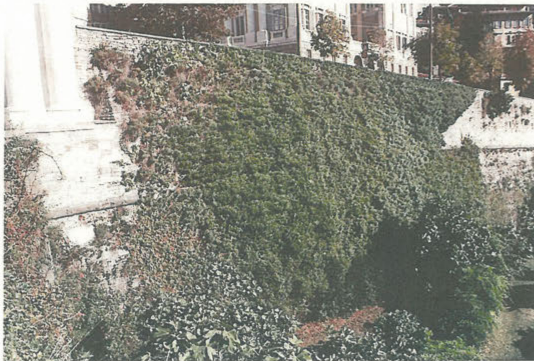
VISTA DI PARTE DEL TRATTO "2" dal Viadotto
