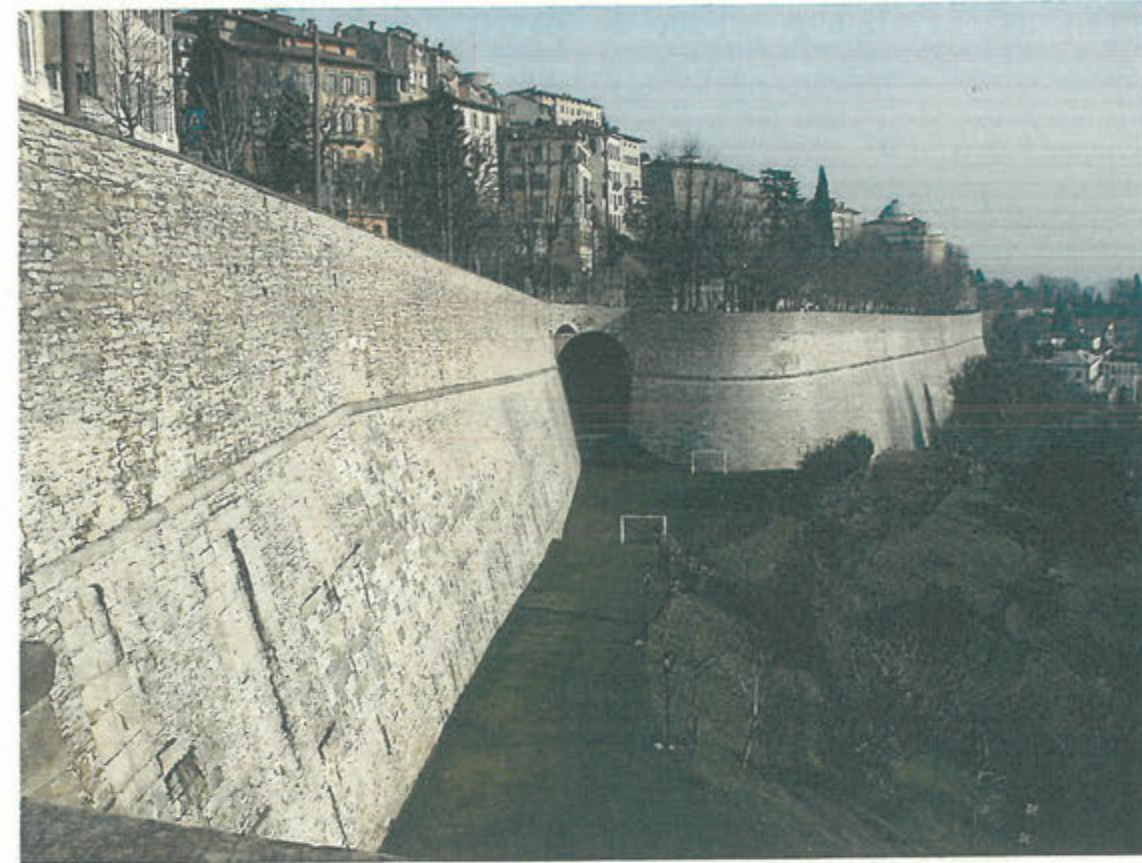
VISTA COMPLESSIVA DELLE MURA DAL VIADOTTO S. GIACOMO
