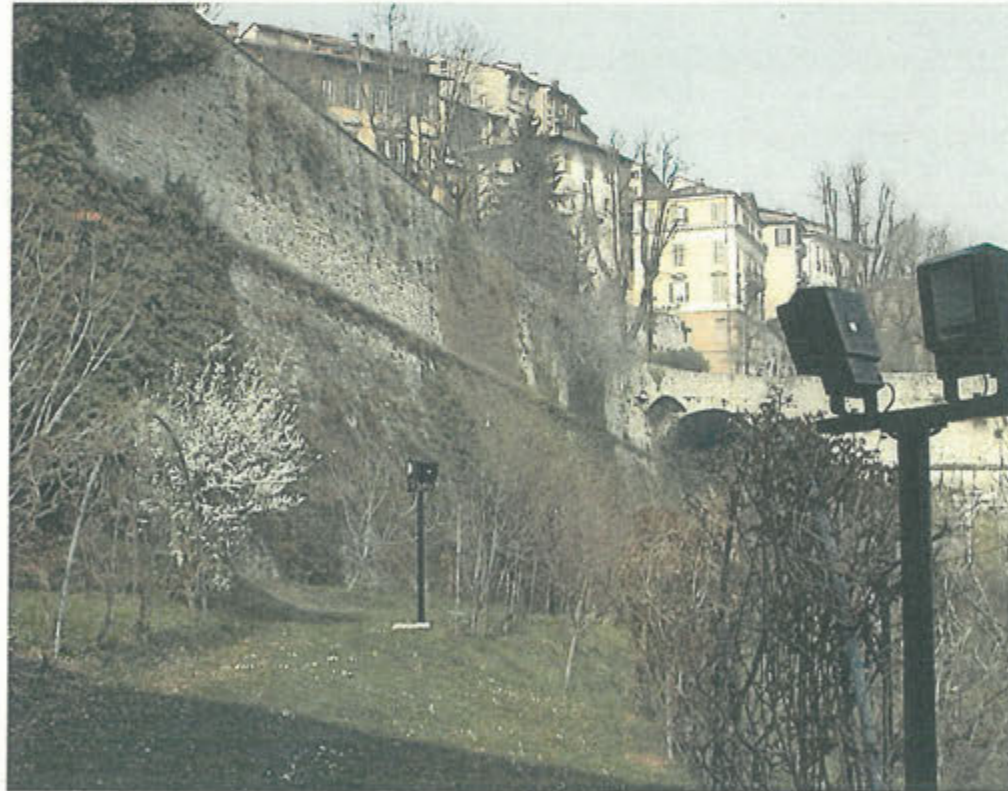
VISTA DAL BASSO DEL TRATTO "2"
