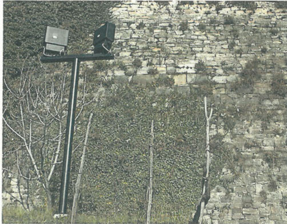
VISTA DAL BASSO PIU' RAVVICINATA DEL TRATTO "2"
