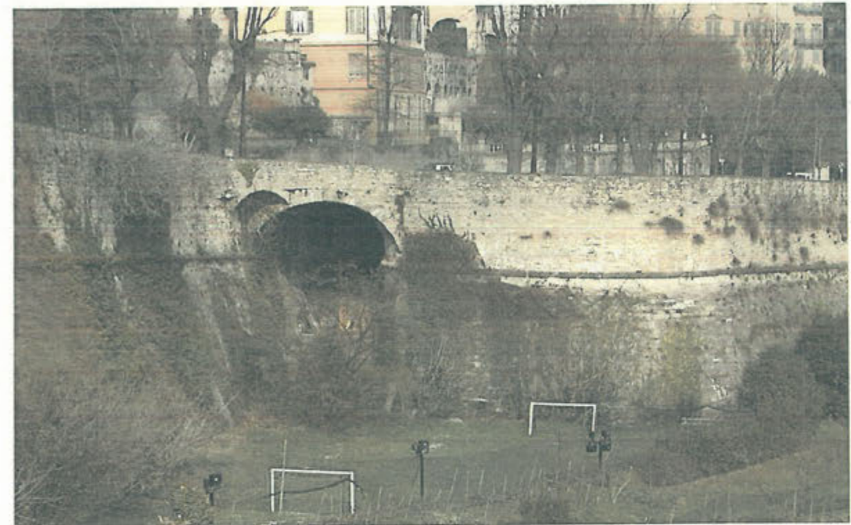
VISTA DELLA PARTE FINALE DEL TRATTO "2" dal Viadotto
