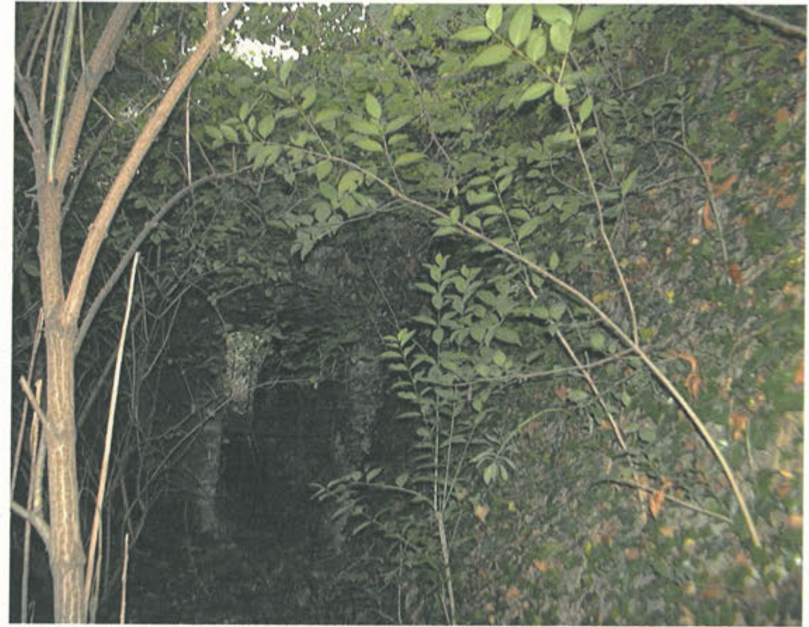
PARTICOLARE DEL PASSAGGIO SOTTO LA FUNICOLARE DI CITTA' ALTA
