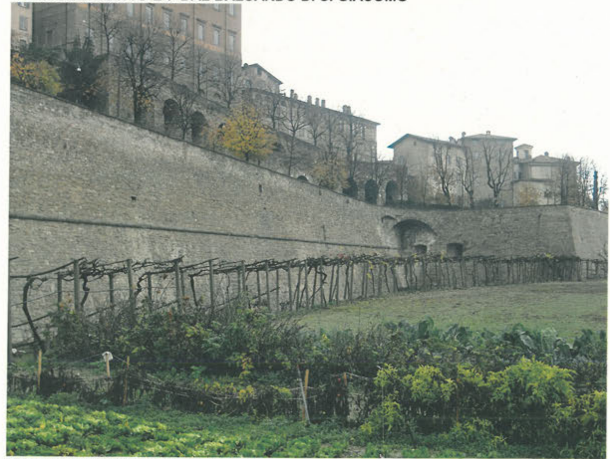
VISTA DEL TRATTO D-E DAL BASSO
