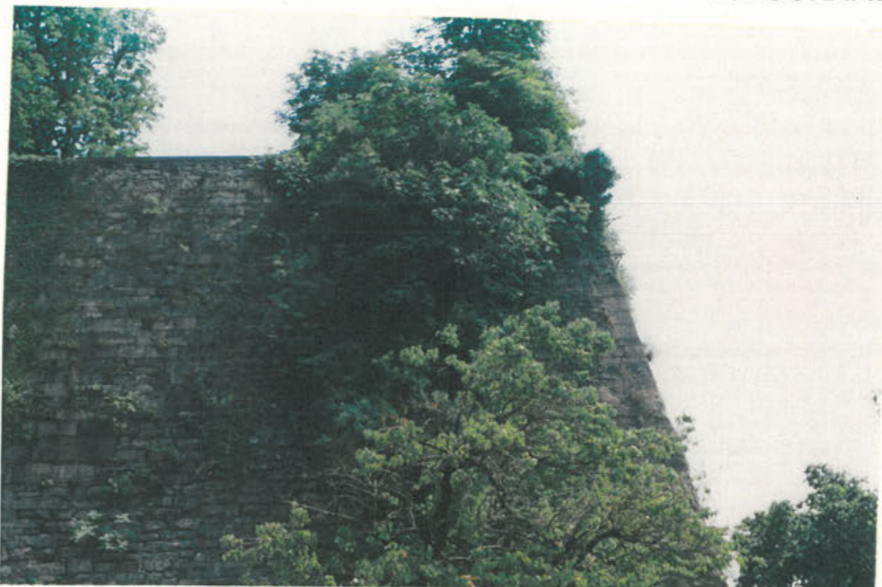
VISTA DEL TRATTO C-D
