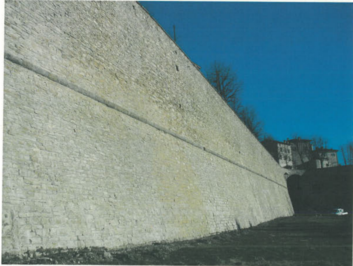
VISTA DEL TRATTO D-E DAL BASSO
