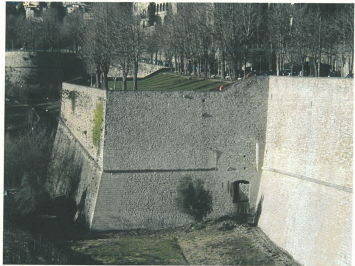
VISTA DEL TRATTO E-F DAL BALUARDO DI S. GIACOMO
