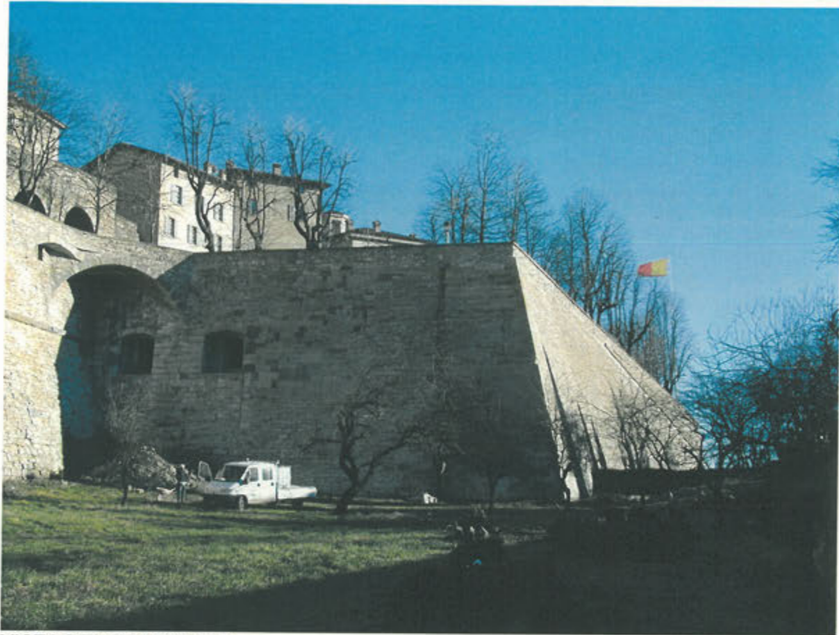
VISTA DEL TRATTO C-D
