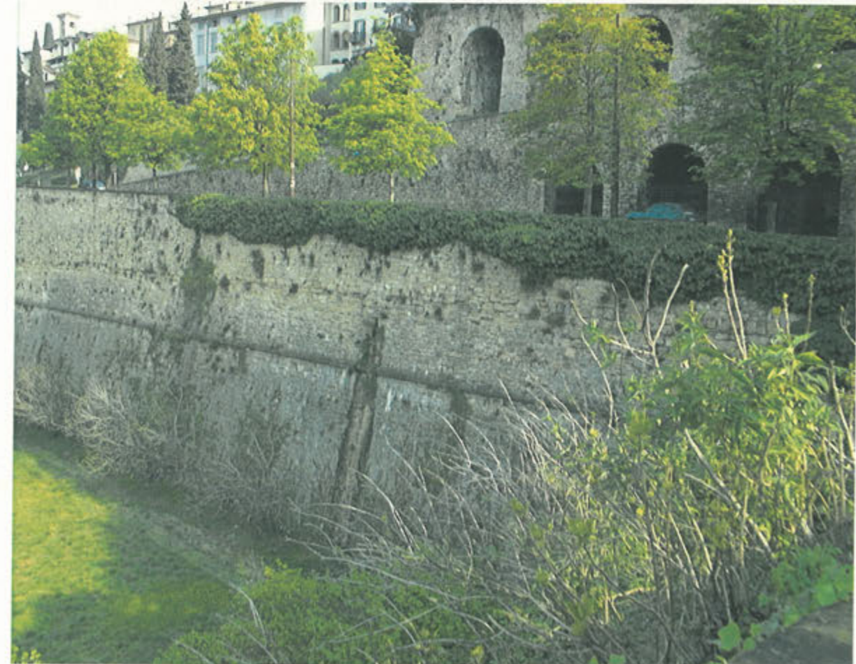
VISTA DI PARTE DEL TRATTO D-E DAL BALUARDO S. GIACOMO
