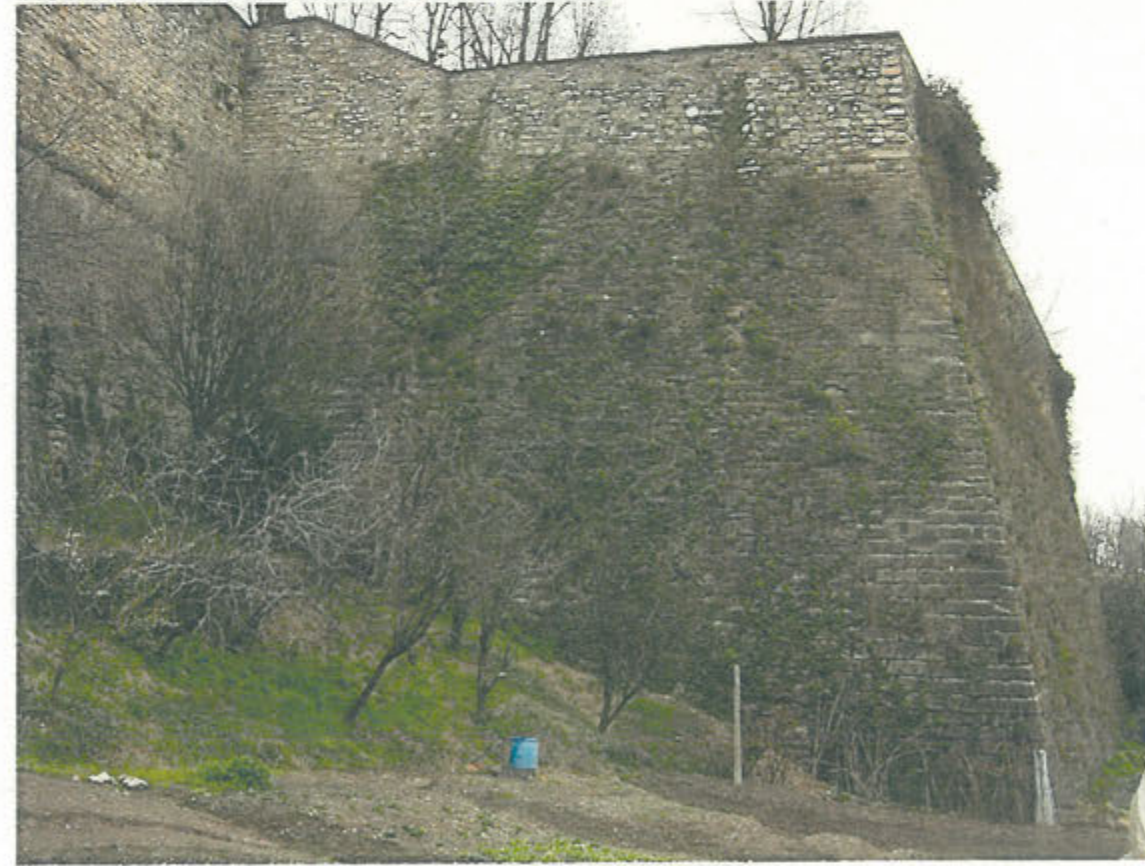
VISTA DELLA PIATTAFORMA DI S. GRATA DAL BASSO
