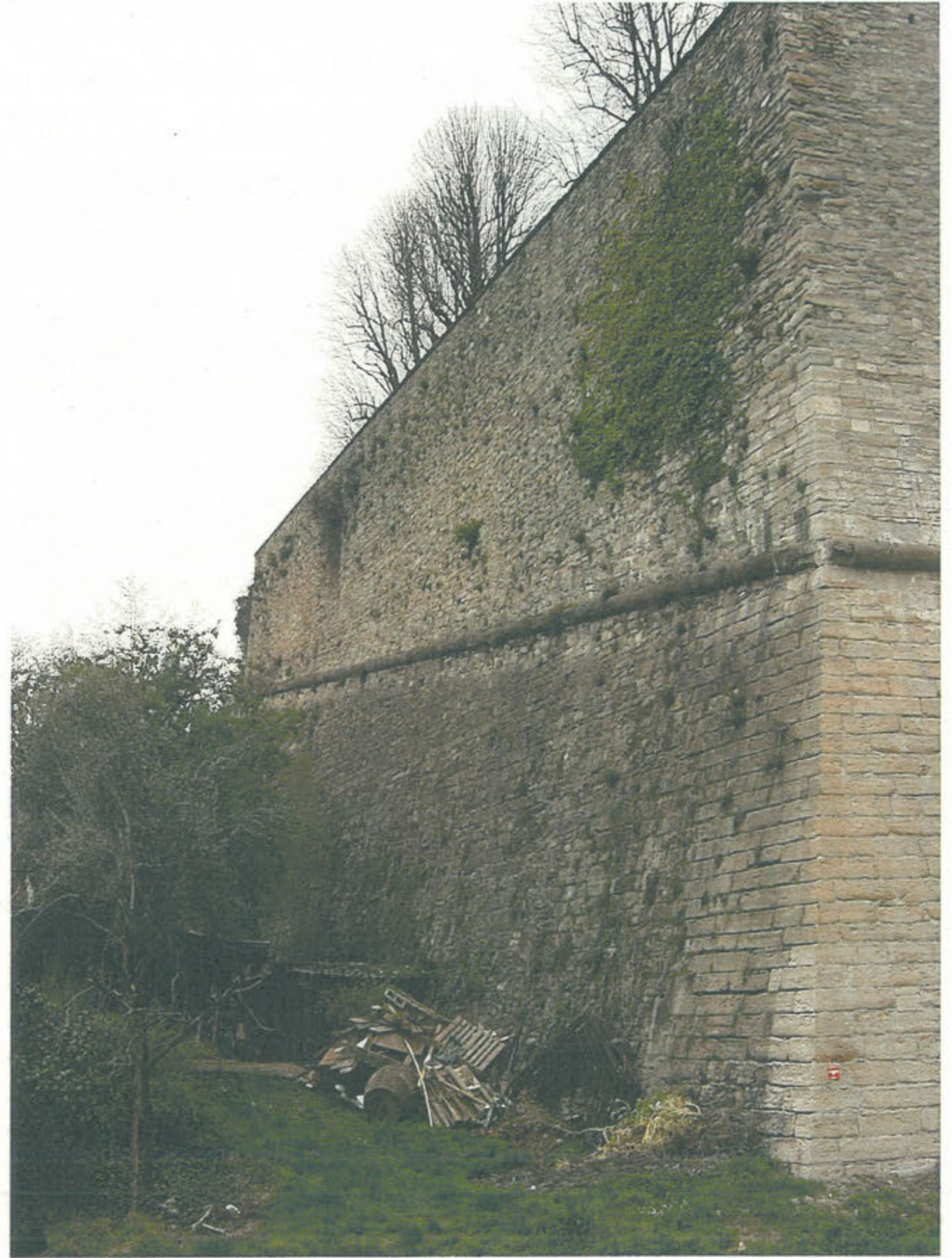
ALTRA VISTA DELLA PIATTAFORMA DI SANTA GRATA
