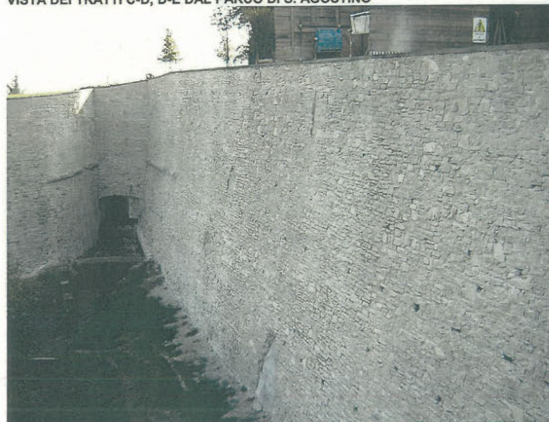
VISTA DEL TRATTO C-D
