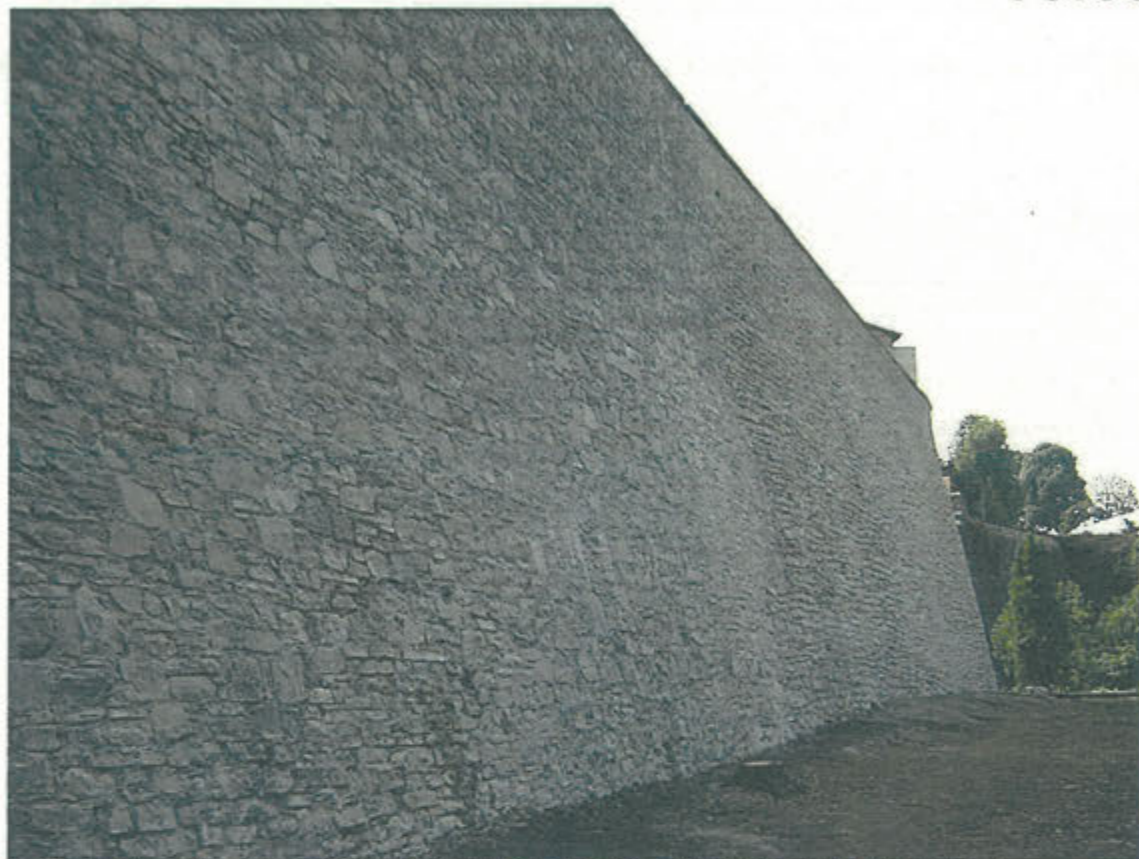
VISTA DEL TRATTO A-B DALLO SPIGOLO DOVE PARTONO LE MURAINE
