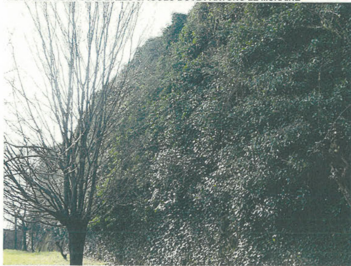
VISTA DEL TRATTO A-B DALLA PARTE OPPOSTA
