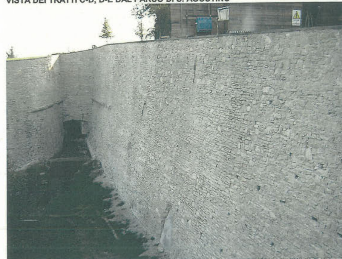
VISTA DEL TRATTO C-D
