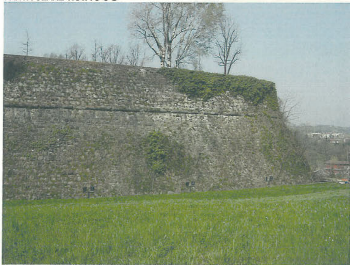
VISTA PARTE TERMINALE TRATTO E-F
