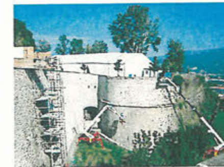
VISTA D'INSIEME DI UN PRECEDENTE INTERVENTO. SI EVIDENZIANO, A TITOLO ESEMPLIFICATIVO, L'AREA DI CANTIERE, IL CASTELLO DI PONTICCO E LE MODALITA' D'INTERVENTO CON LE PIATTAFORME AEREE
