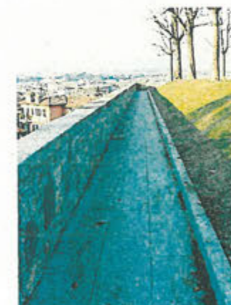
VISTA DI UN PRECEDENTE TRATTO GIÀ REALIZZATO A TITOLO ESEMPLIFICATIVO
