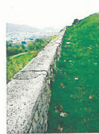
VISTA DEL LATO INTERNO DEL PARAPETTO DEL TRATTO NM
