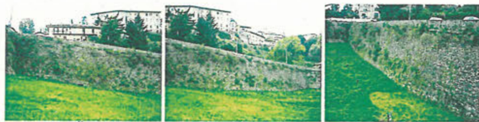
06 Vista della parte iniziale del tratto O-P 07 Vista della parte finale del tratto O-P 08 Vista del tratto O-P dal viadotto di S. Lorenzo
