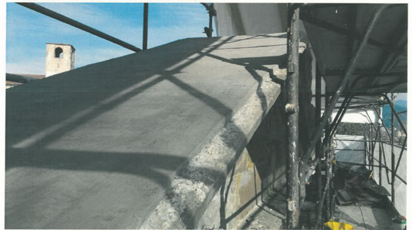
La superficie ultimata pronta a ricevere la lattroneria in rame
