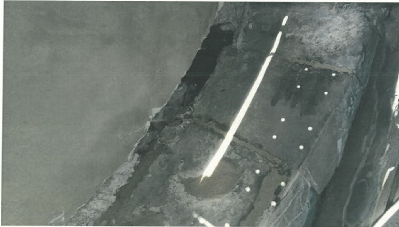
Il ripristino delle sigillature tra i diversi conci di pietra e la muratura
