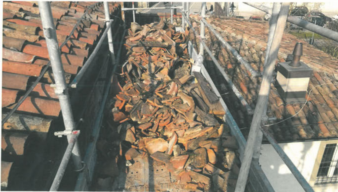
I coppi rotti sostituiti durante la ricorritura
