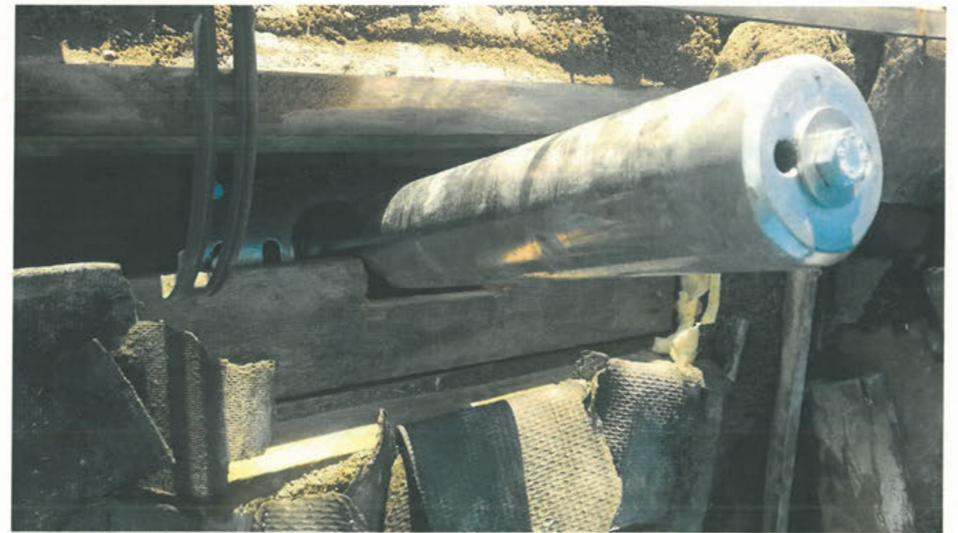
La posa del palo della linea vita, fissato alla trave di colmo sottostante
