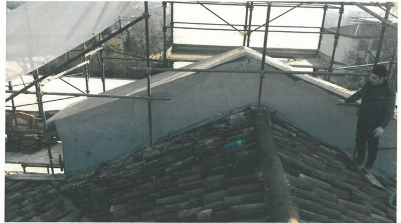
L'intonaco realizzato a protezione
