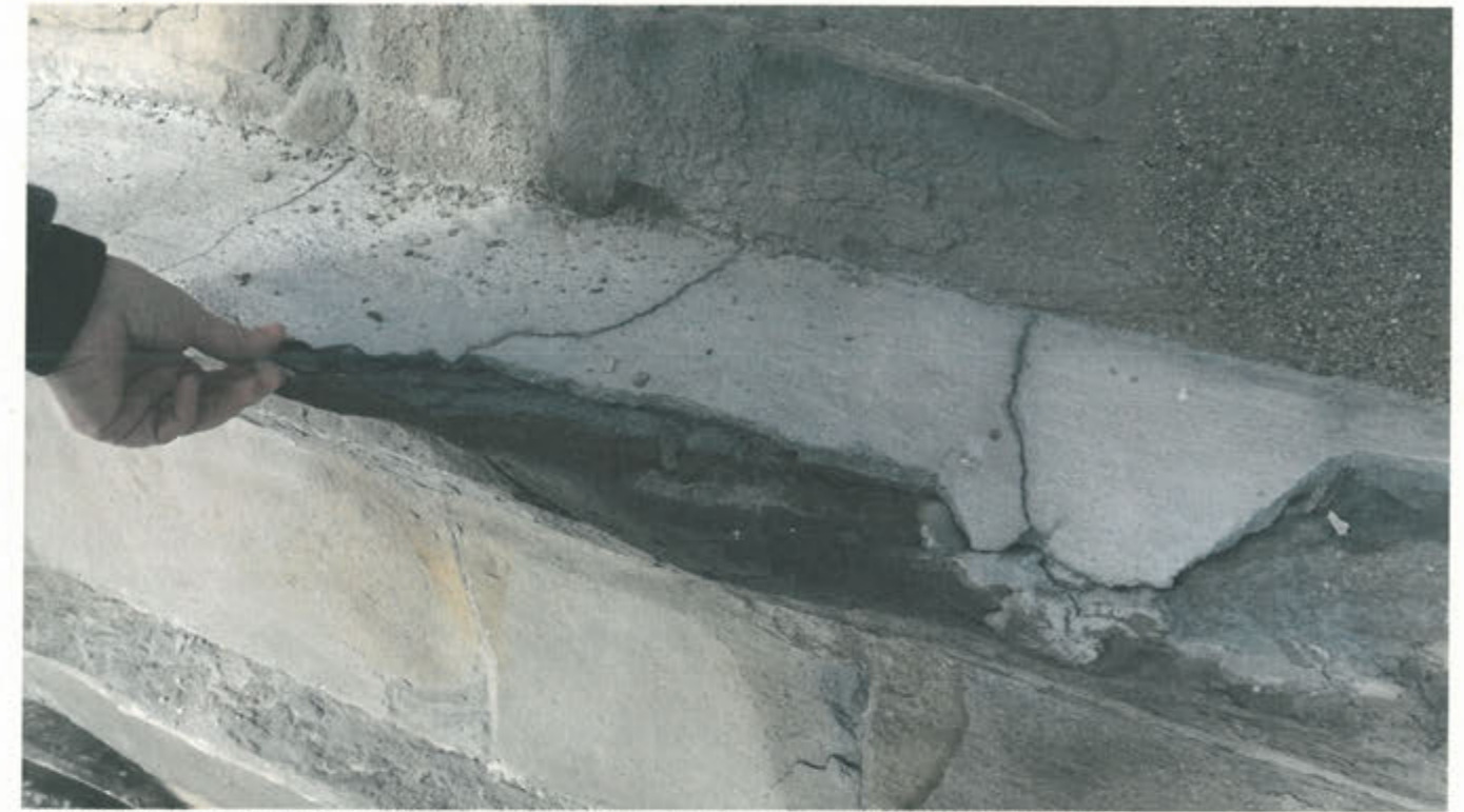
La rimozione delle incongrue malte cementizie poste su alcune fasce marcapiano
