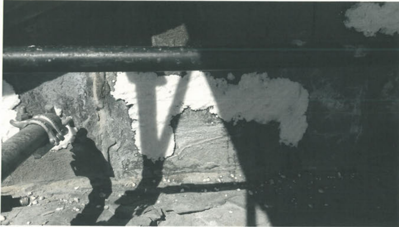
La pulitura localizzata mediante impacchi
