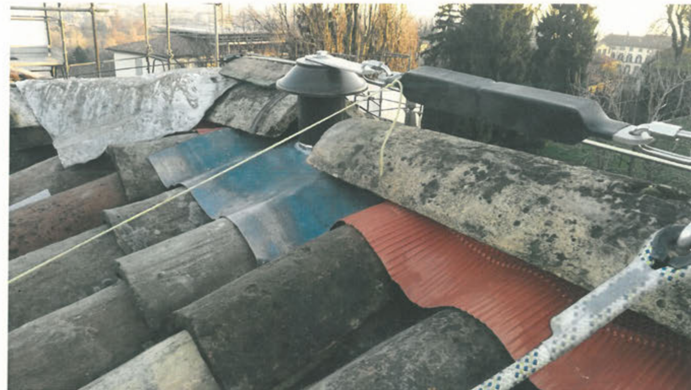
La posa della bandella per il colmo ventilato e la sostituzione dei coppi normali con copponi, si vede anche il palo della linea vita con apposita lattoneria
