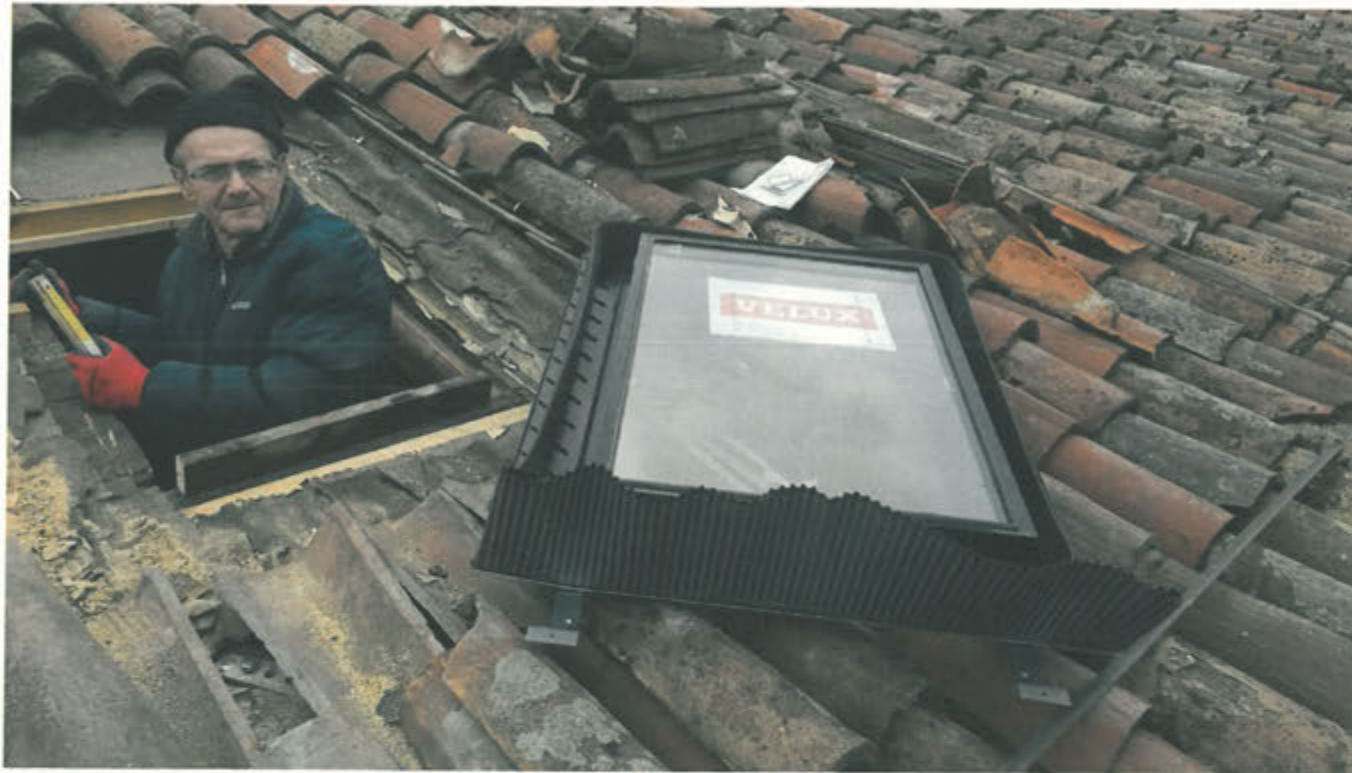
La posa del nuovo lucernaio, posizionato in un punto più facilmente accessibile
