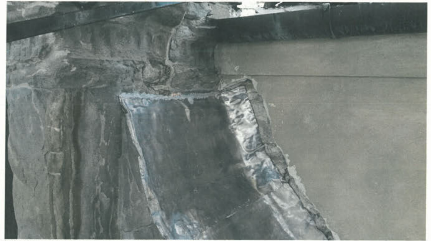
La successiva posa delle nuove lattonerie in piombo
