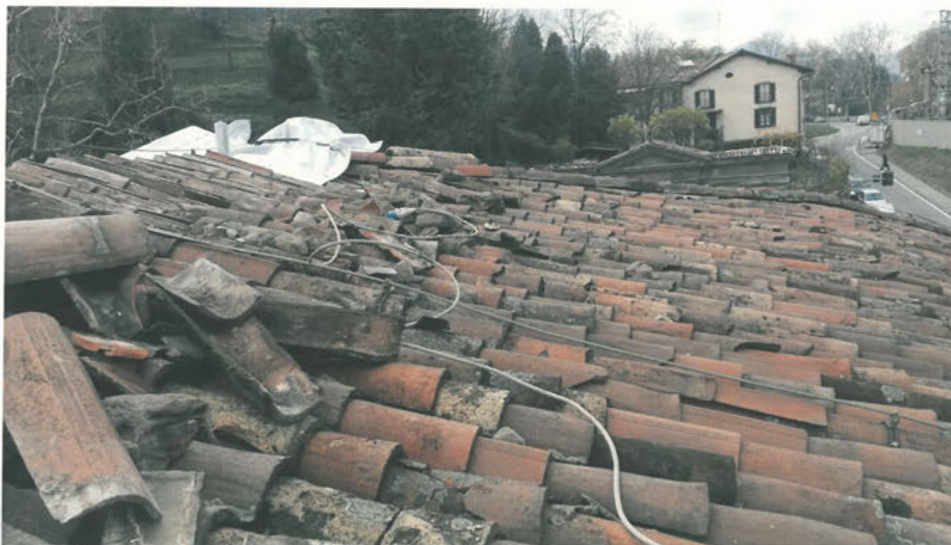
La ricorritura della copertura nella parte alta del colmo
