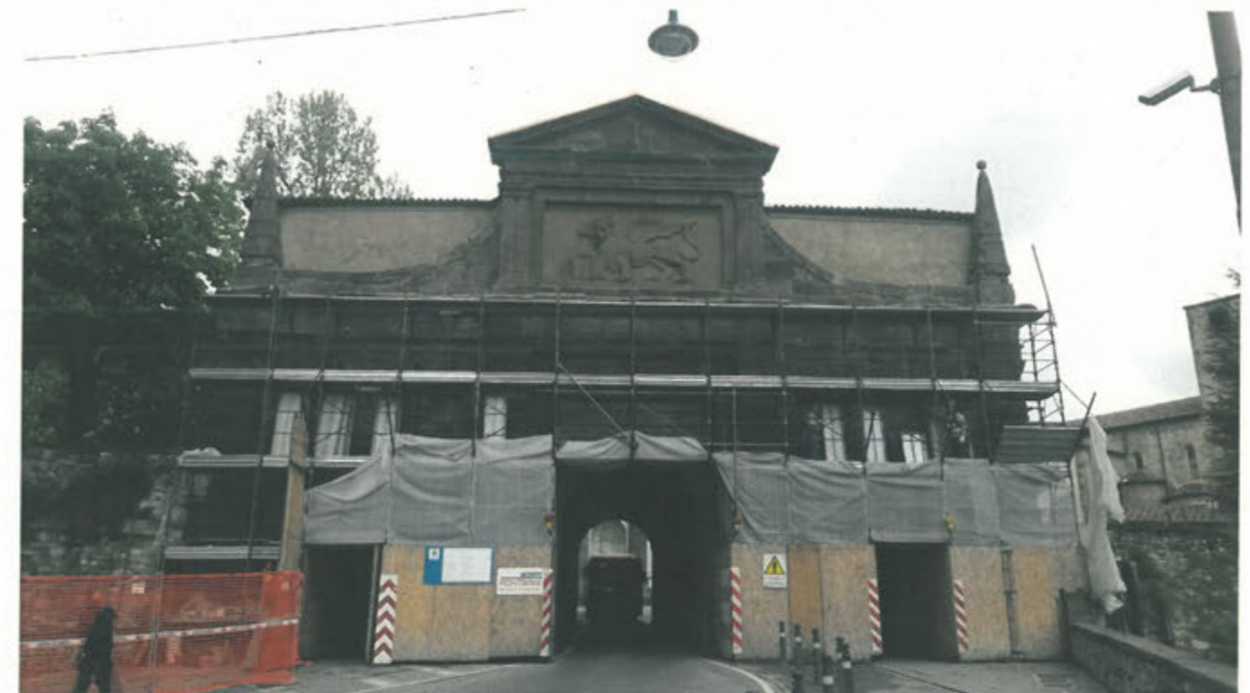
Lo smontaggio dei ponteggi, si nota la facciata ancora bagnata per il trattamento idrorepellente dato il giorno prima
