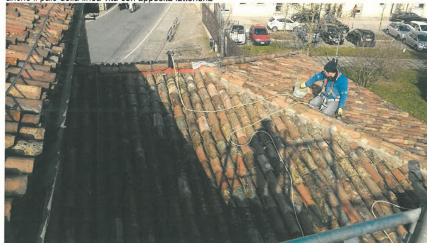
La ricorritura dell'edificio basso, realizzata mediante la linea vita installata, in particolare la sigillatura dei displuvi con la malta
