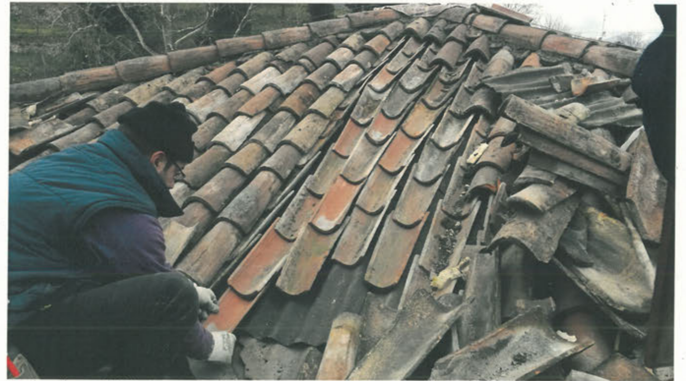
La rimozione dell'abbaino esistente e il ripristino della copertura
