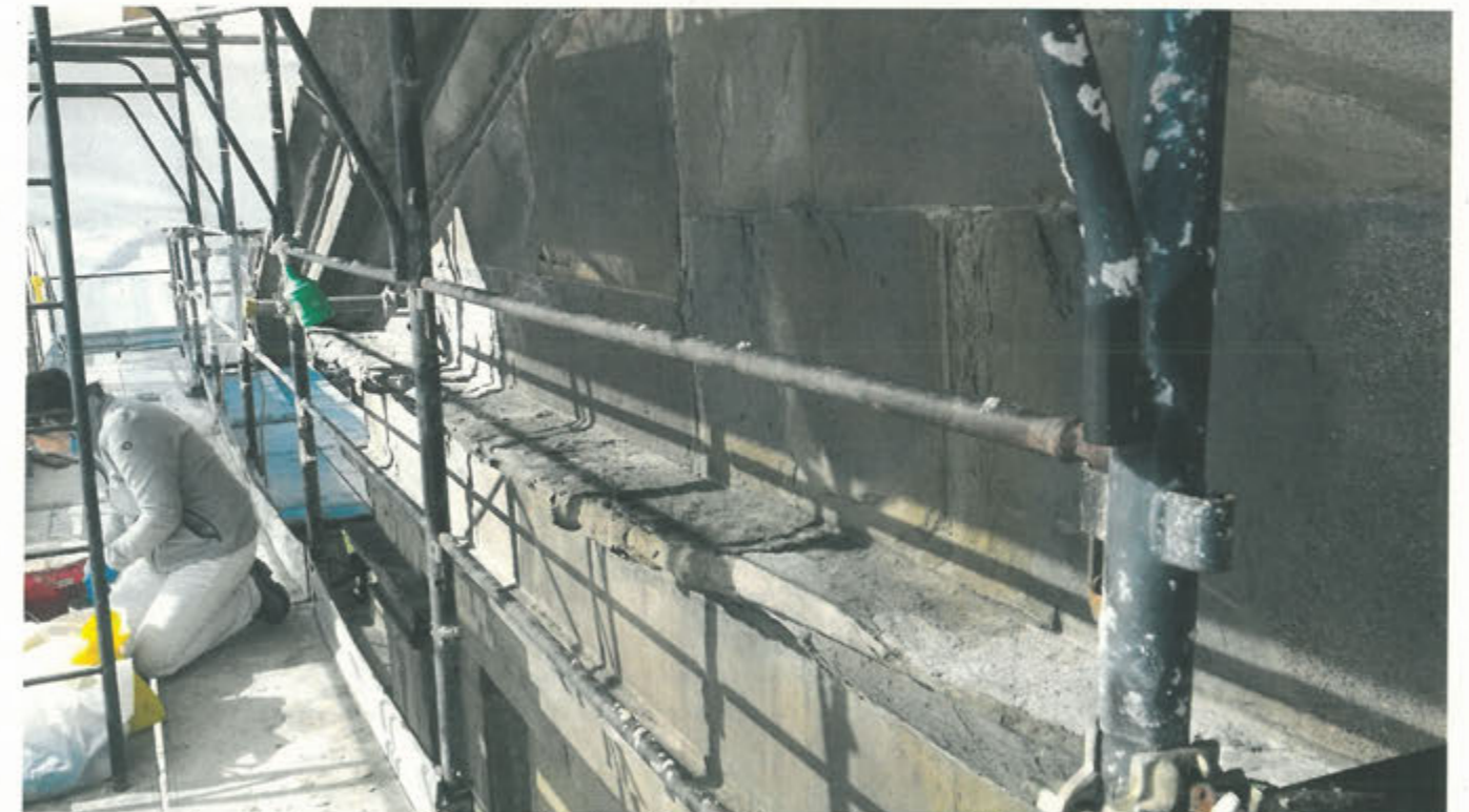
La preparazione della superficie dopo la rimozione delle malte cementizie
