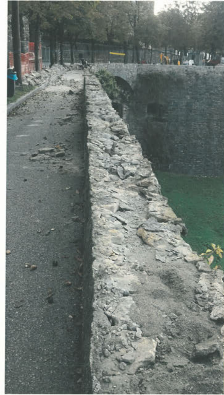
CAMPIONE DI COPERTINA CON TRATTAMENTO INVECCHIANTE
