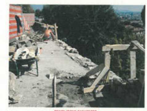
DEMOLIZIONE PARAPETTO
