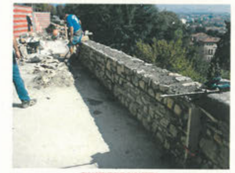
RICOSTRUZIONE PARAPETTO
