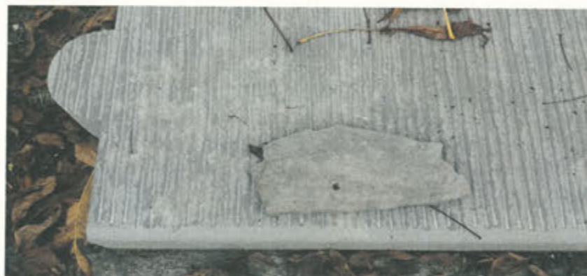
CAMPIONE IN OPERA DI COPERTINA VELATA CON PARAPETTO
