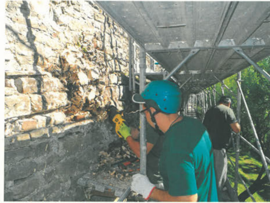
26 – ficus durante rimozione
