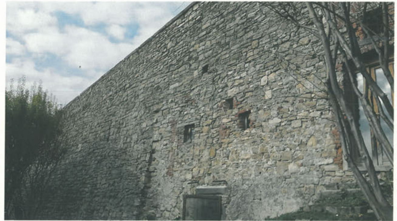
MURATURA – lato proprietà privata a valle
