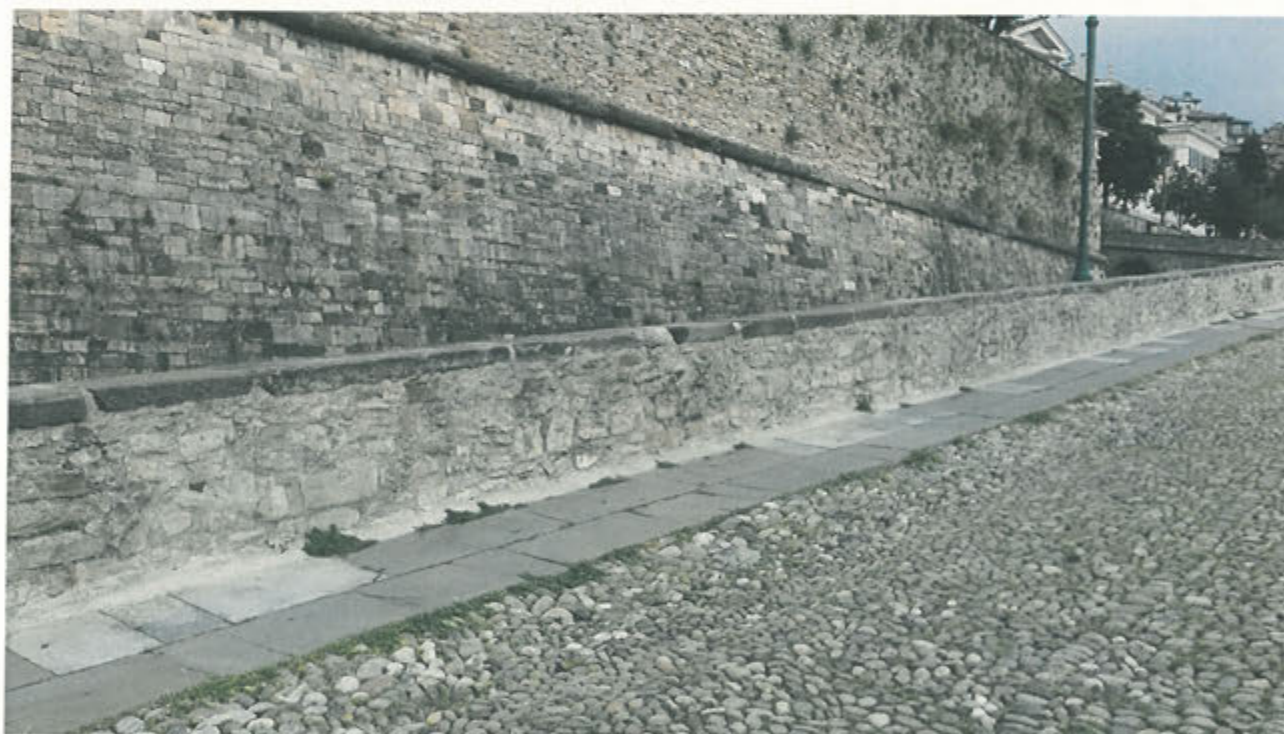
LATO INTERNO PARAPETTO – lato a monte
