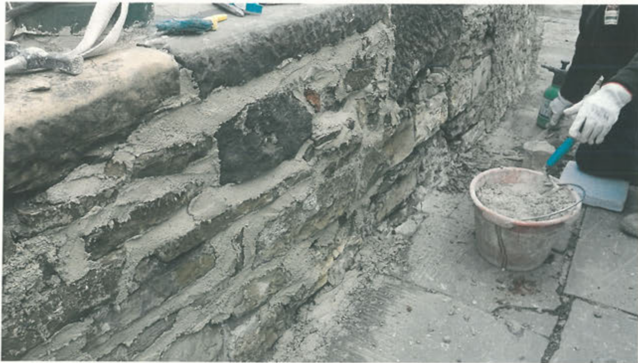
LATO INTERNO PARAPETTO - Dopo il lavaggio con idropulitrice si è proceduti alla risarcitura delle malte con effetto "coprente"
