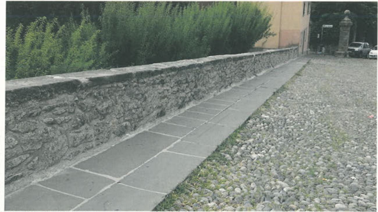
LATO INTERNO PARAPETTO – lato a valle
