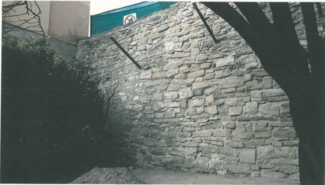
MURATURA – lato proprietà privata a valle
