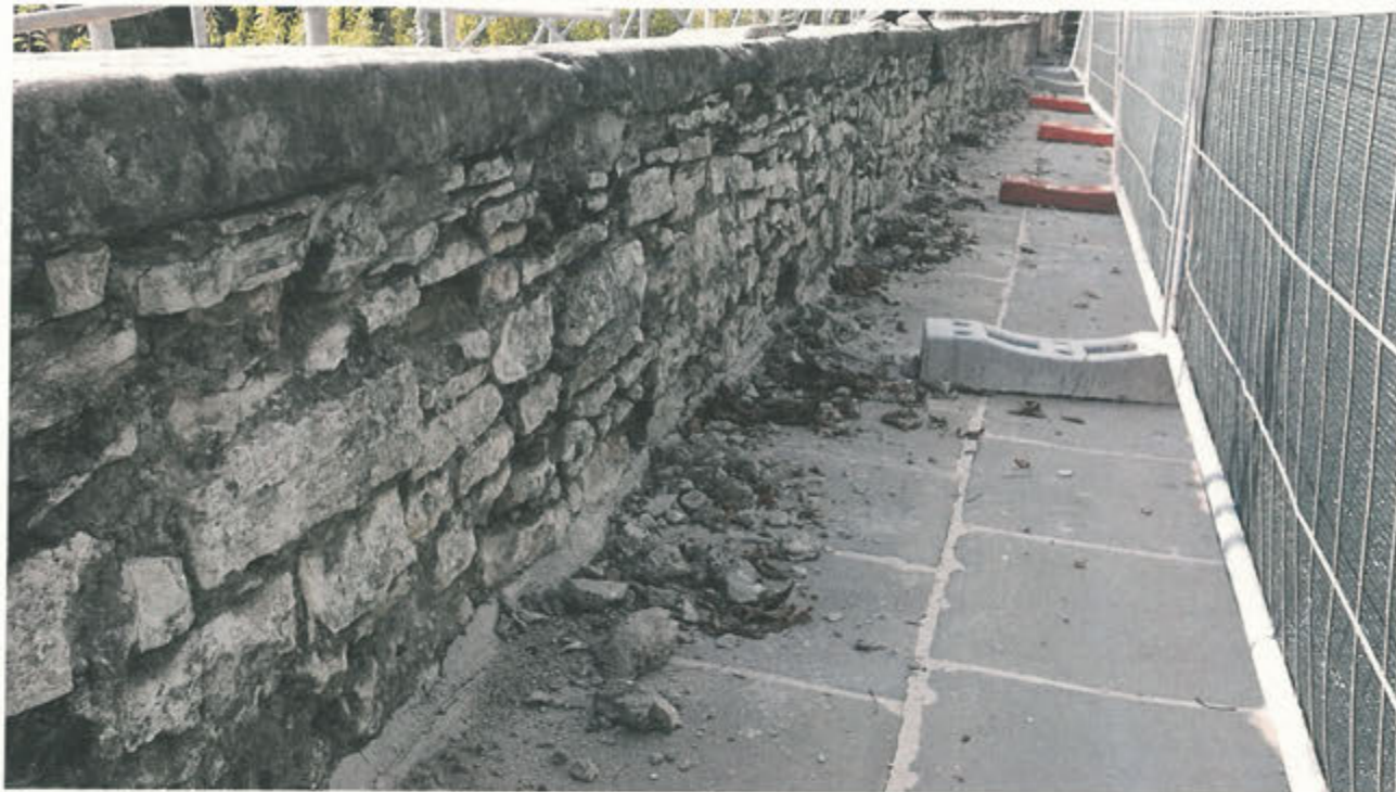
LATO INTERNO PARAPETTO - Rimozione malte cementizie, distaccate e/o in fase di distacco
