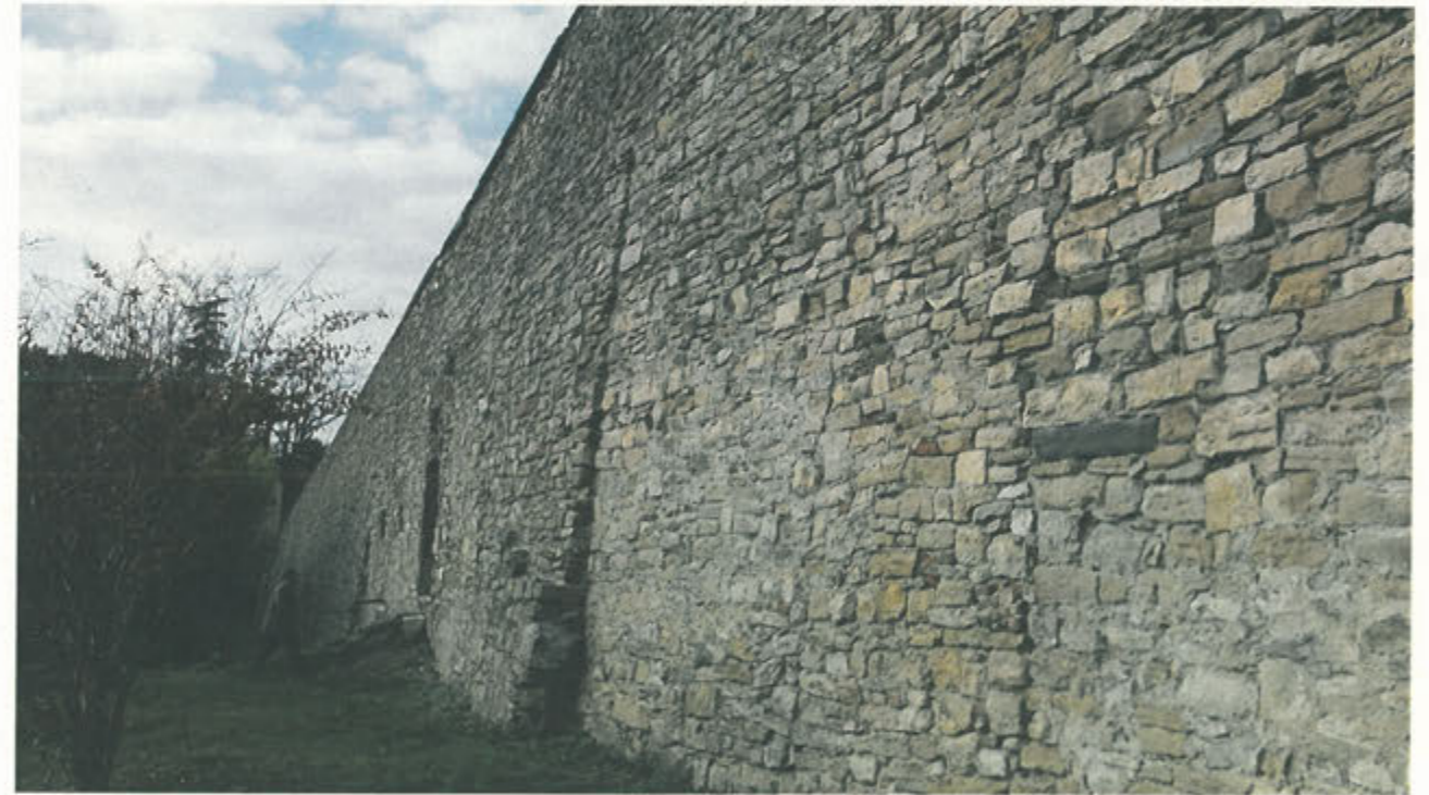
MURATURA – lato proprietà privata a valle
