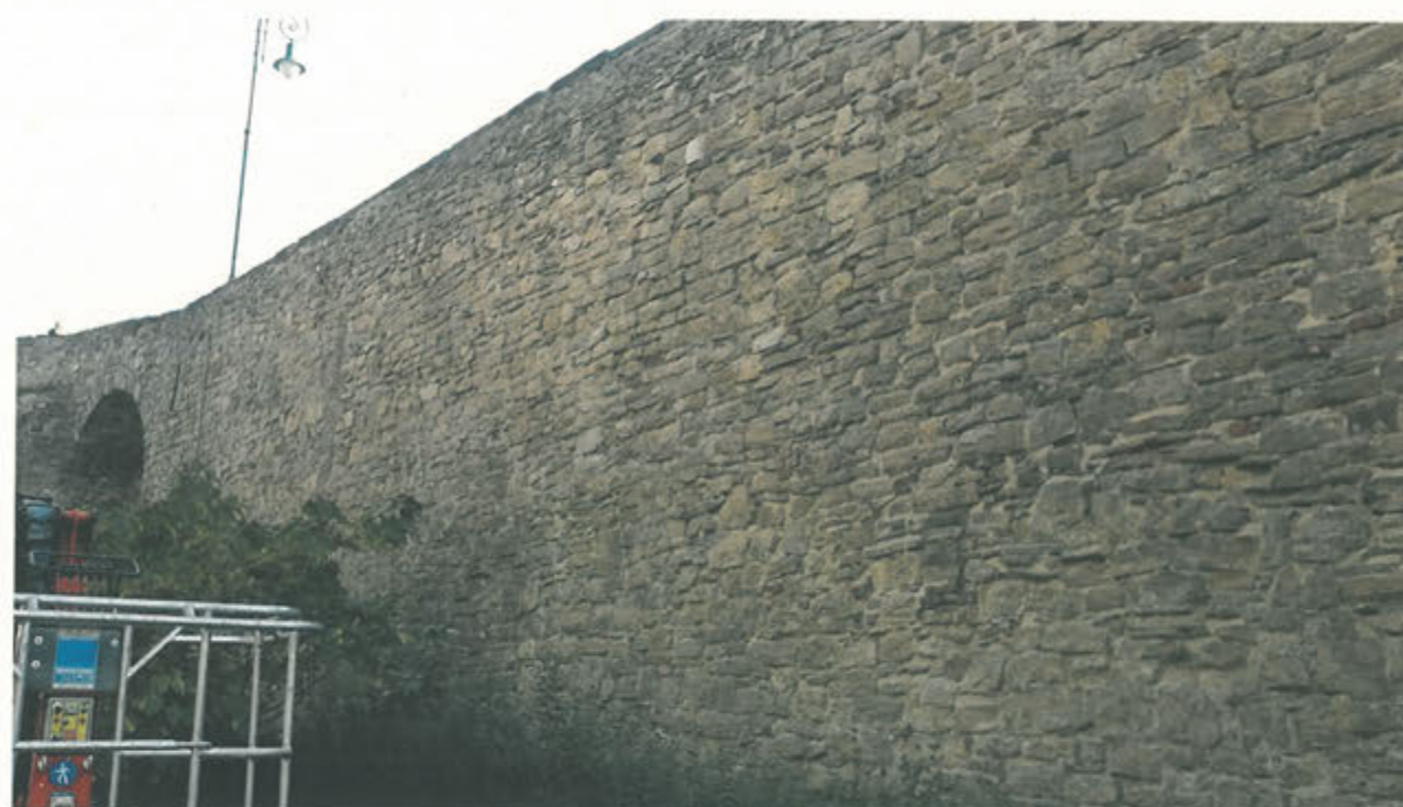
MURATURA – lato orti a monte
