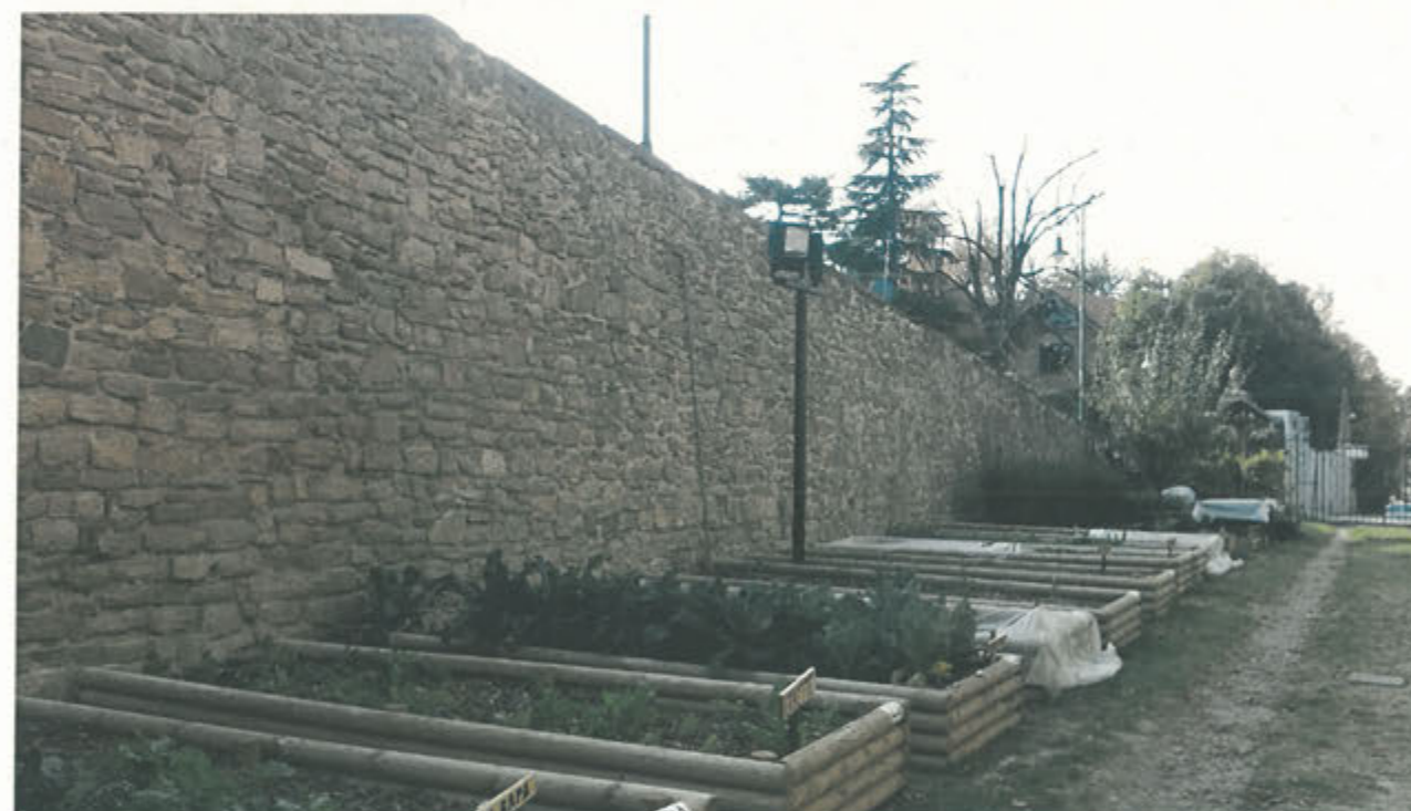
MURATURA – lato orti a monte
