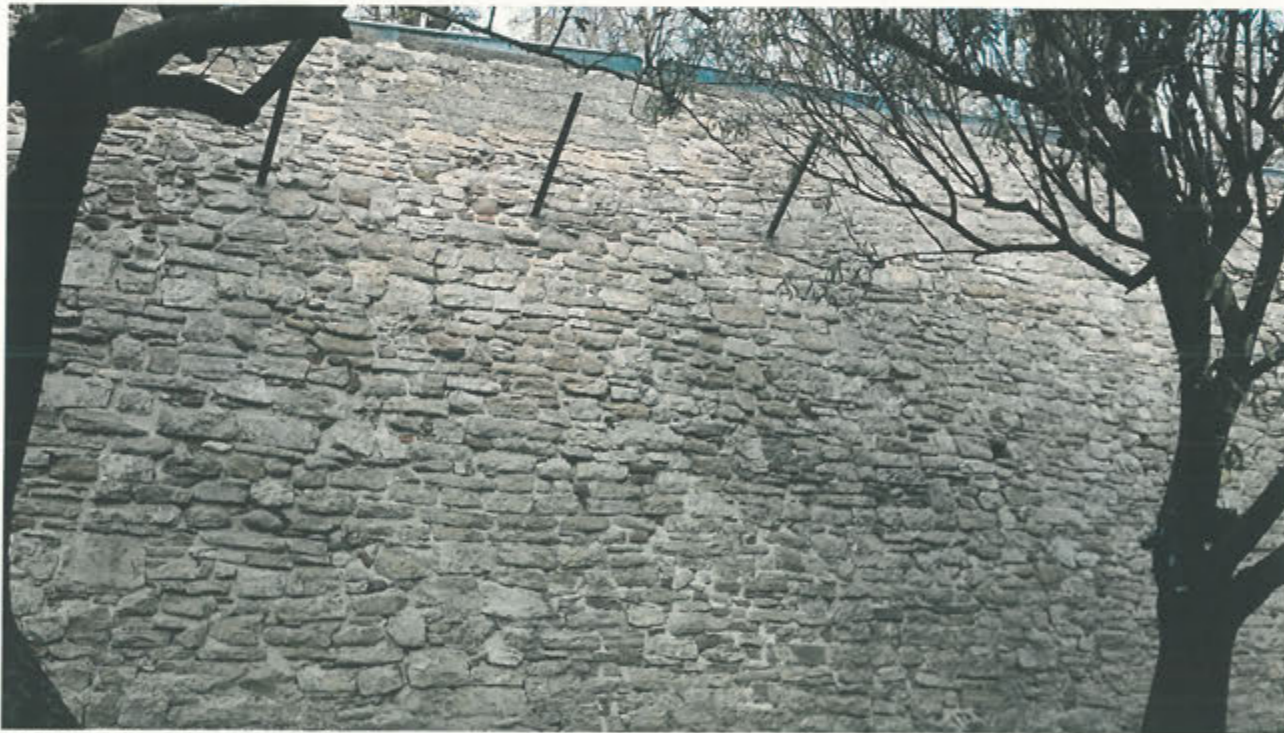
MURATURA – lato proprietà privata a valle
