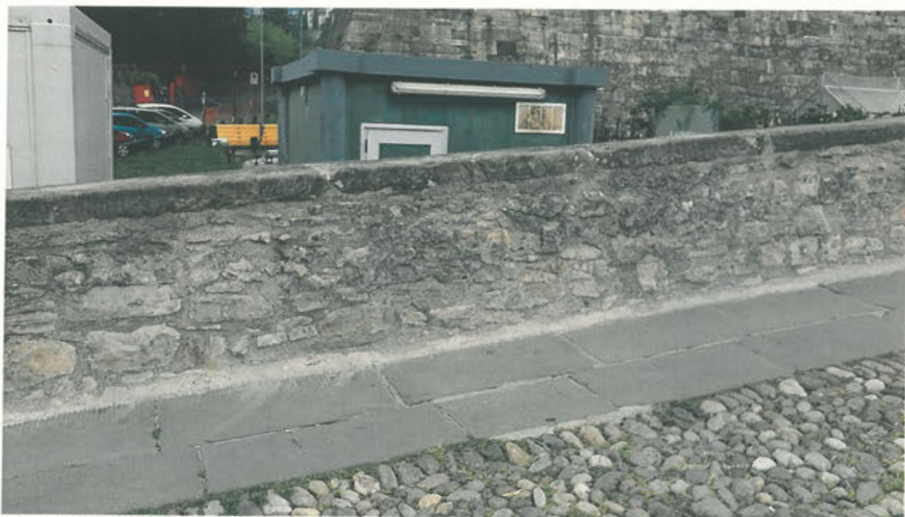
LATO INTERNO PARAPETTO – lato a monte
