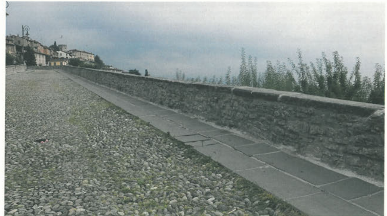
LATO INTERNO PARAPETTO – lato a valle
