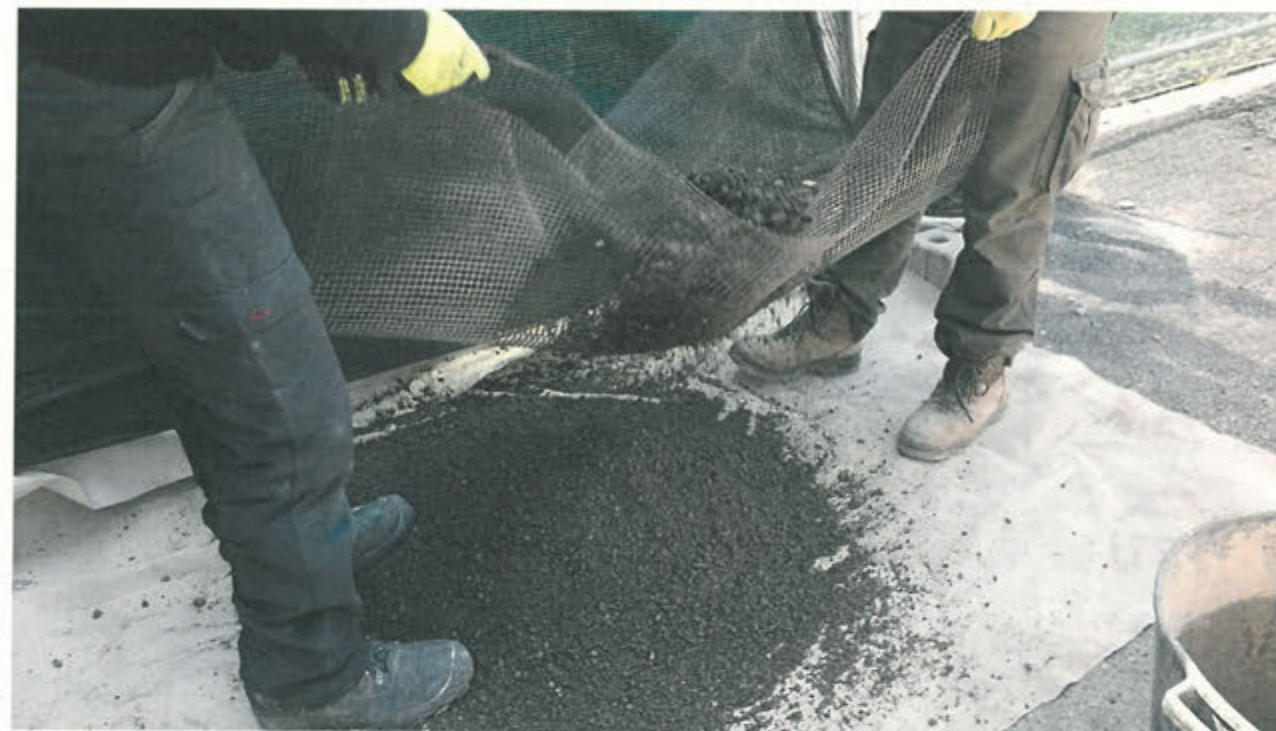
LATO INTERNO PARAPETTO – Setacciatura degli inerti per la rimozione di quelli più grossolani
