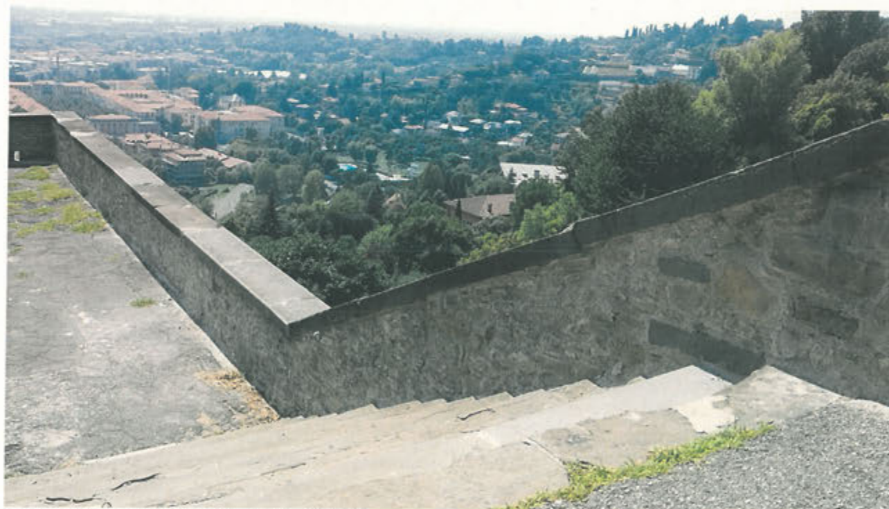
LATO INTERNO PARAPETTO – tratto C9-C10
