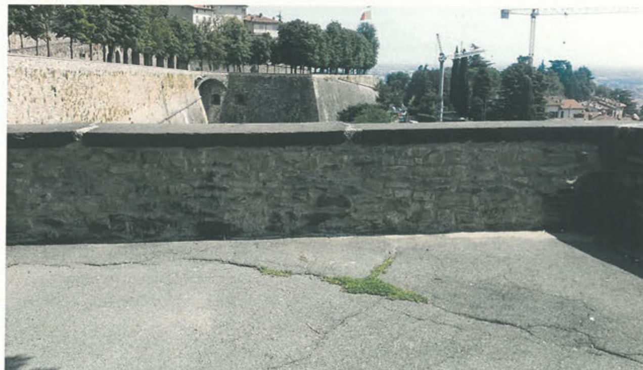
LATO INTERNO PARAPETTO – tratto C7-C8
