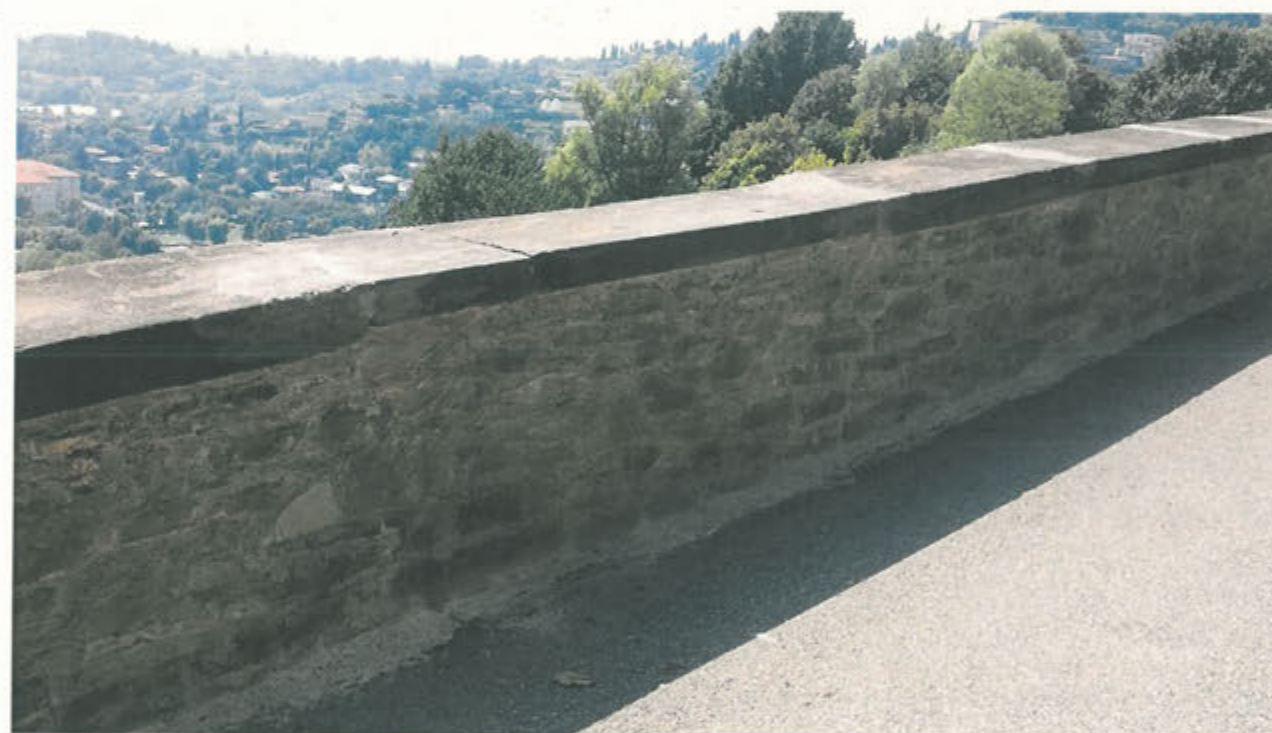
LATO INTERNO PARAPETTO – tratto C10-C11
