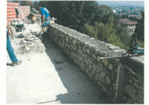
RICOSTRUZIONE PARAPETTO
