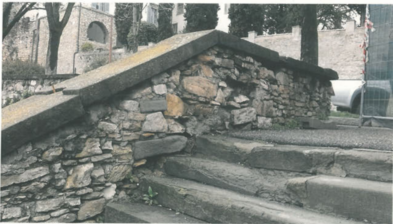
LATO INTERNO PARAPETTO – Dopo rimozione malte cementizie, distaccate e/o in fase di distacco tratto C9-C10
