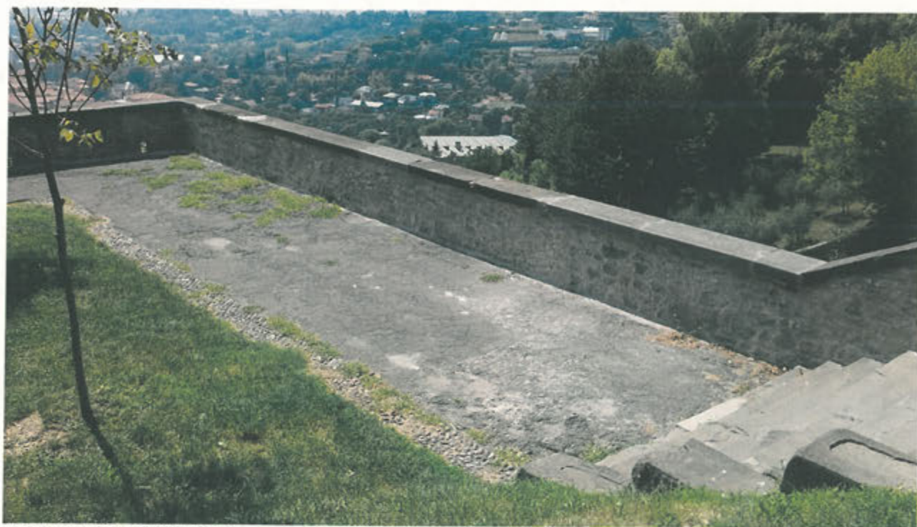
LATO INTERNO PARAPETTO – tratto C9-C10
