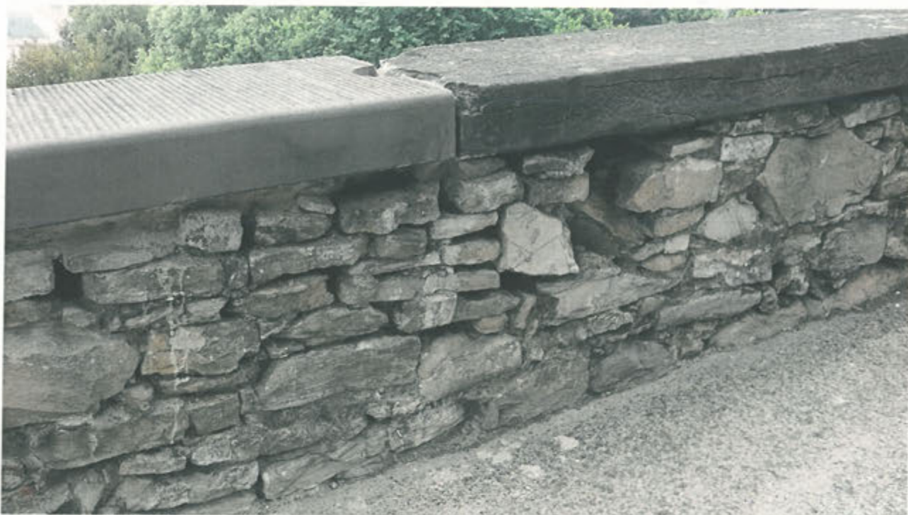
LATO INTERNO PARAPETTO – ricostruzione con cuci-scuci e risarcitura delle malte tratto C10-C11 con sostituzione copertina
