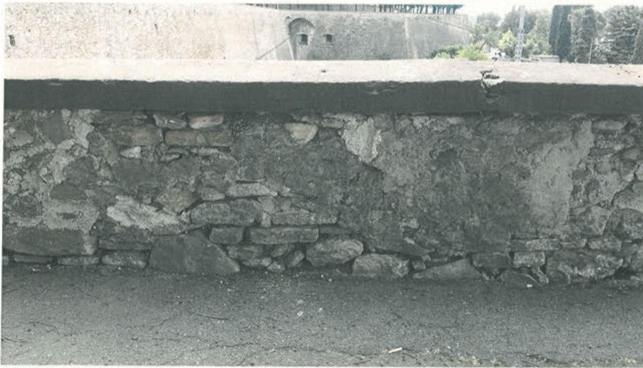
LATO INTERNO PARAPETTO – stato di fatto tratto C7-C8
