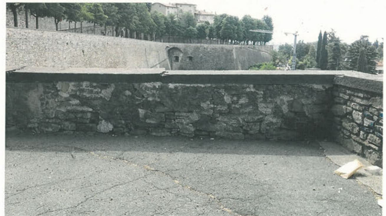
LATO INTERNO PARAPETTO – stato di fatto tratto C7-C8
