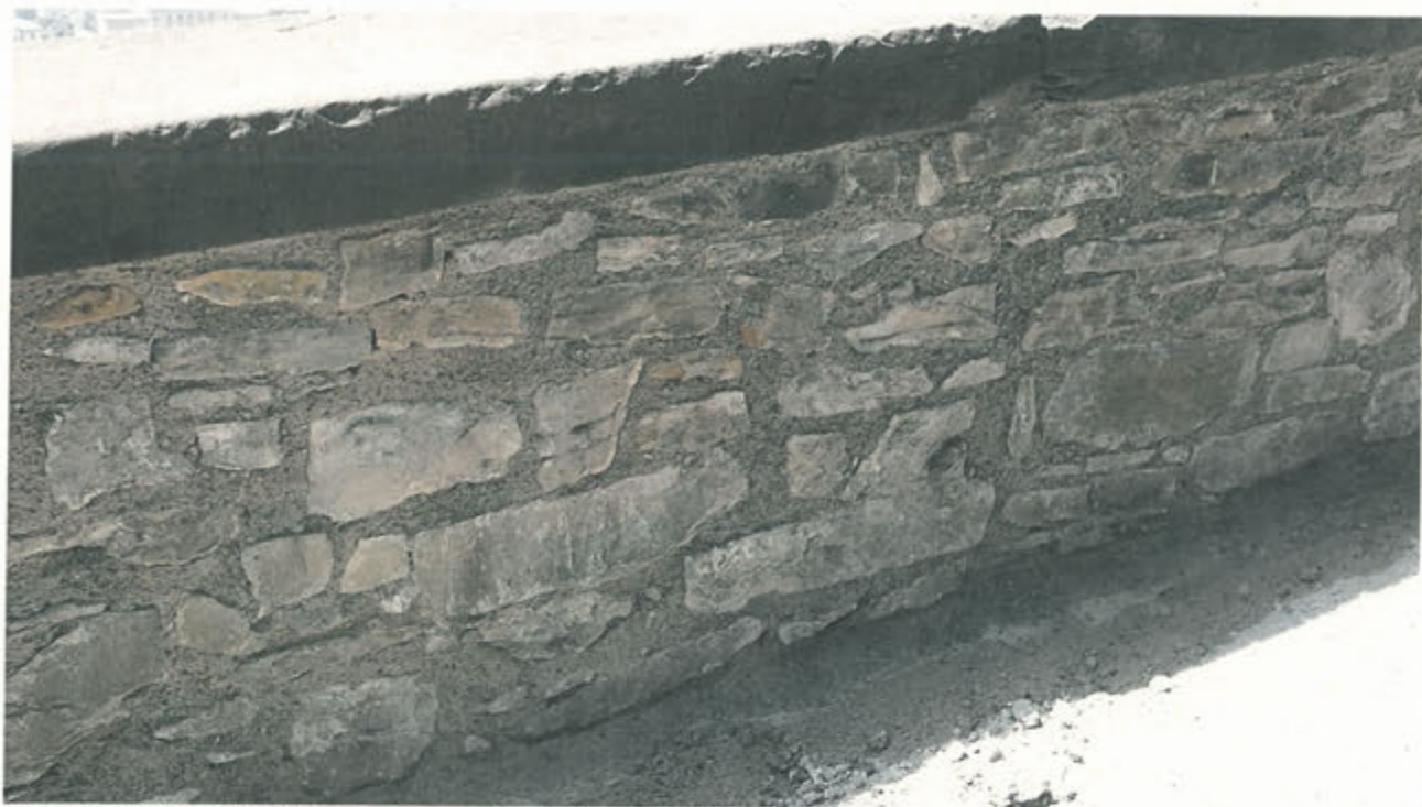
LATO INTERNO PARAPETTO – particolare tratto C10-C11
