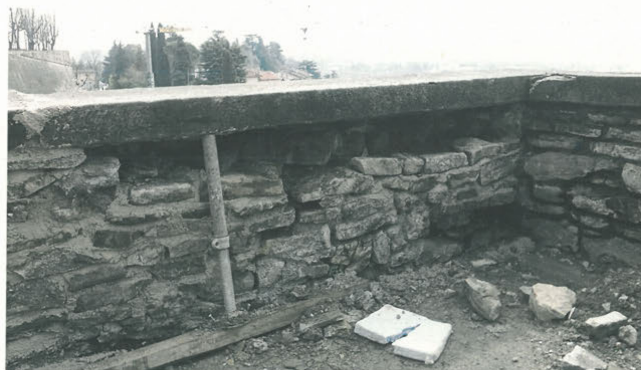
LATO INTERNO PARAPETTO – Dopo rimozione malte cementizie, distaccate e/o in fase di distacco tratto C7-C8
