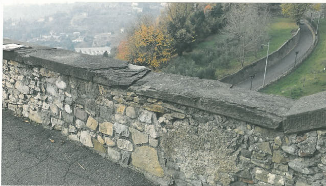
LATO INTERNO PARAPETTO – stato di fatto tratto C9-C10
