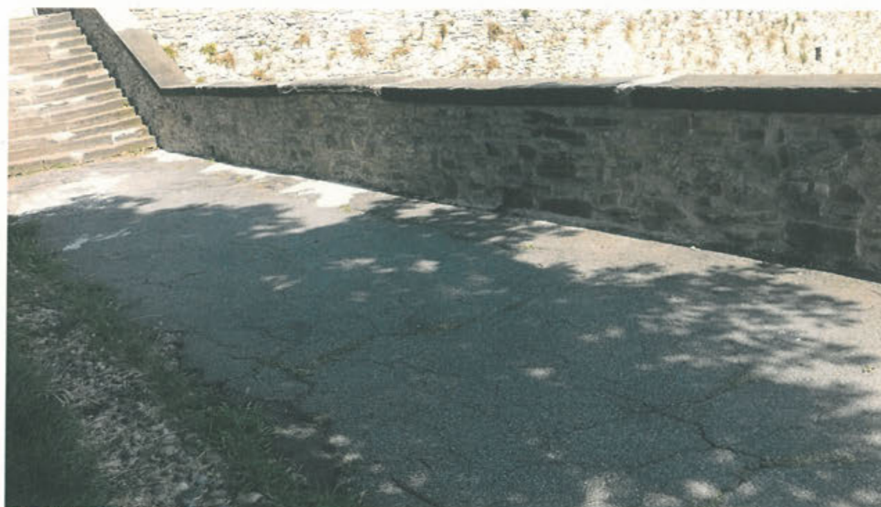
LATO INTERNO PARAPETTO – tratto C7-C8
