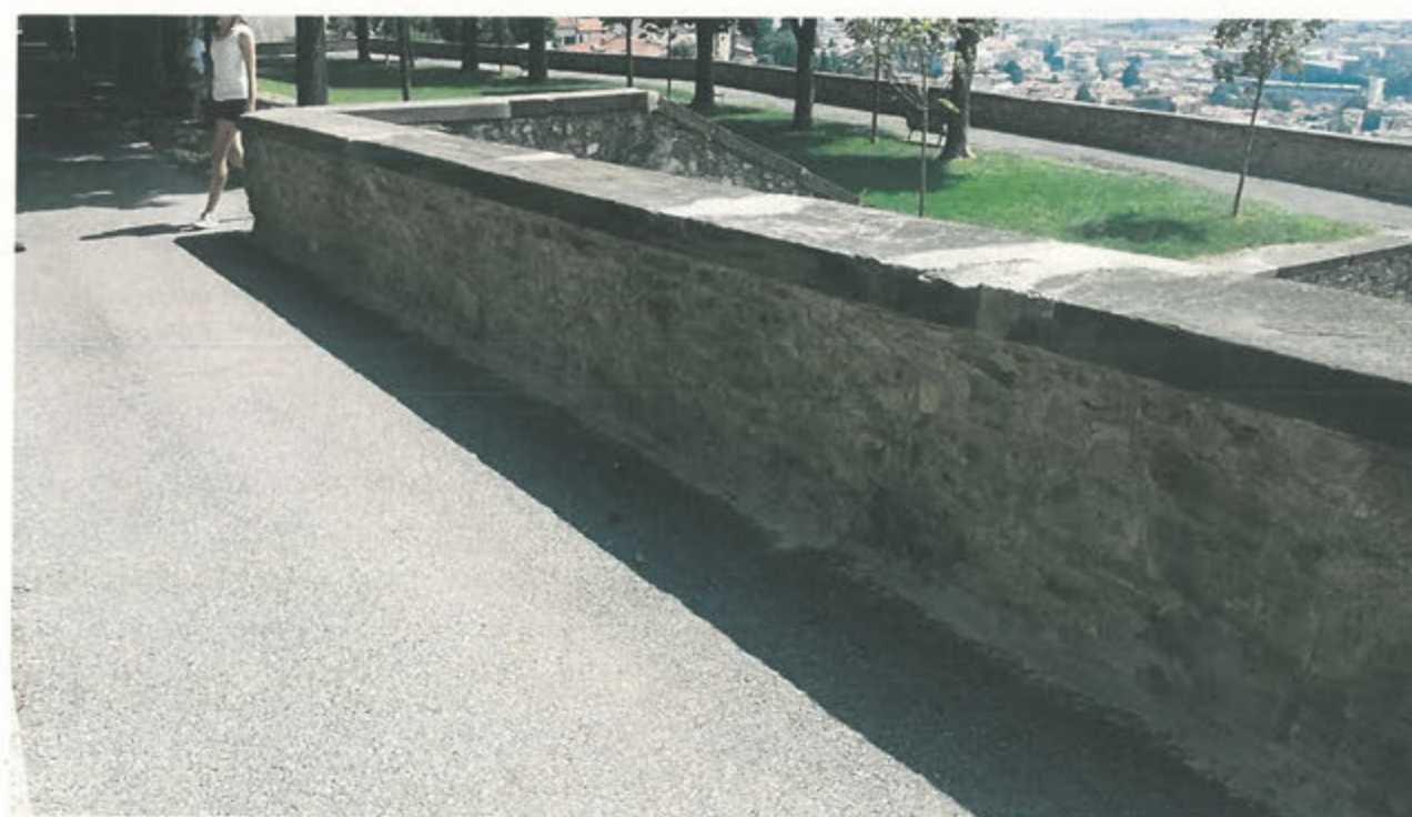
LATO INTERNO PARAPETTO – tratto C10-C11
