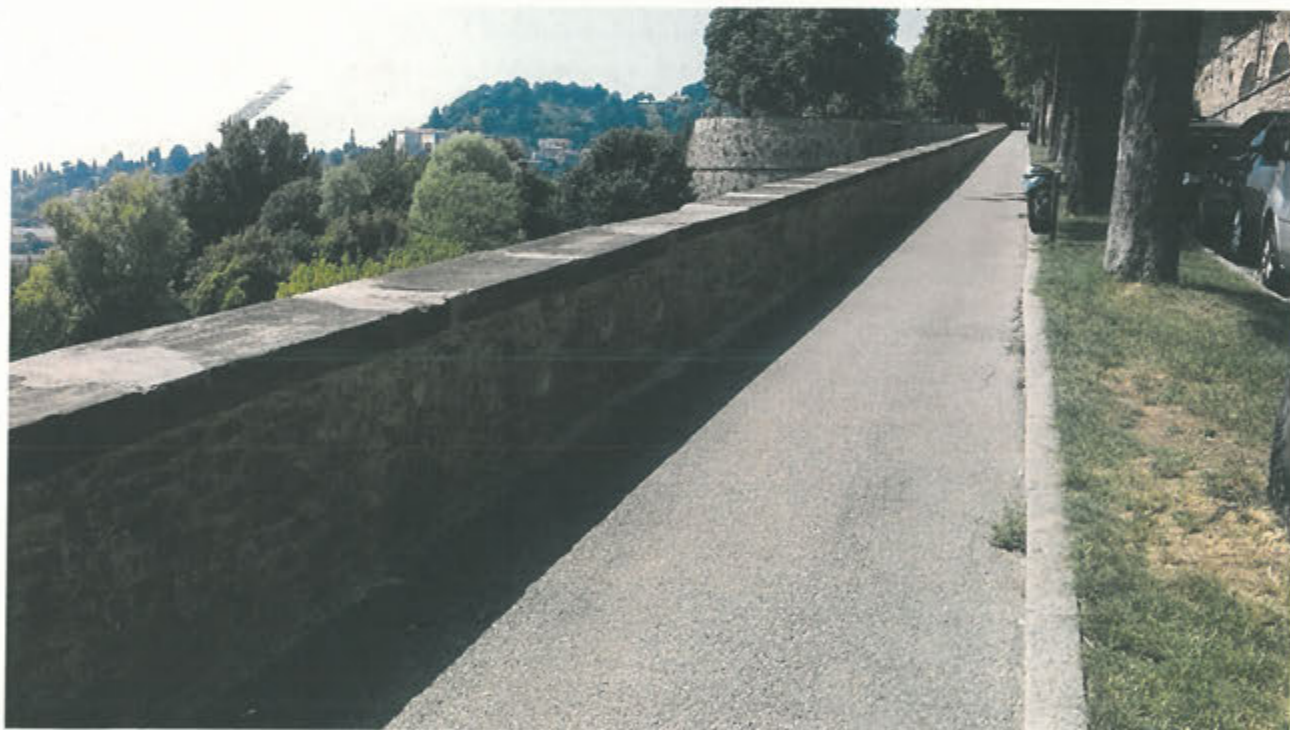
LATO INTERNO PARAPETTO – tratto C10-C11
