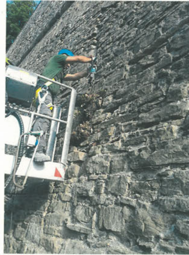
CORTINA DI S. ANDREA –trapanatura radici e inserimento diserbante
