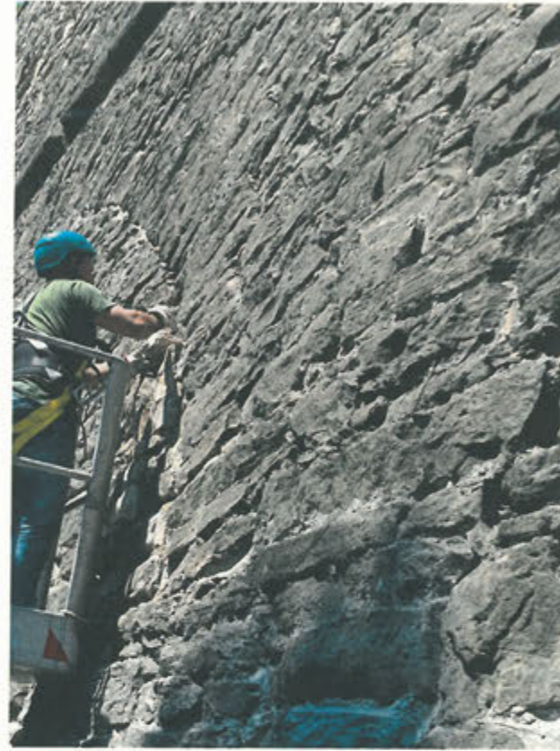
CORTINA DI S. ANDREA –ripristino mancanze con materiale di recupero e sigillature
