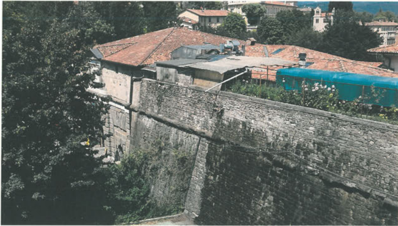
RIPRESE FOTOGRAFICHE DOPO RIMOZIONE VEGETAZIONE, A PARTIRE DALLA PORTA DI S. ALESSANDRO
