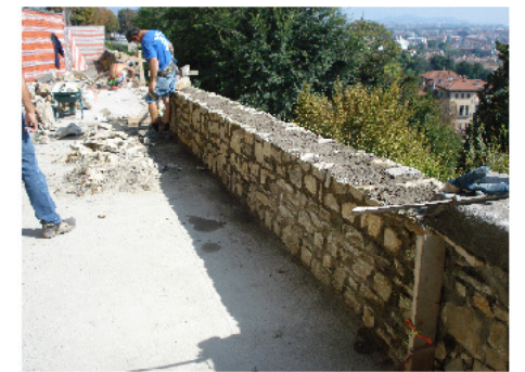
RICOSTRUZIONE PARAPETTO
