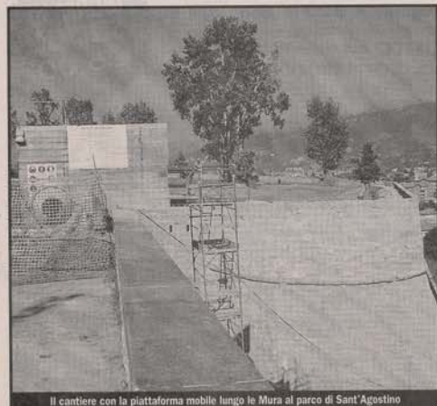
Il cantiere con la piattaforma mobile lungo le Mura al parco di Sant'Agostino
