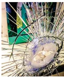
I danni alla vetrina del negozio
