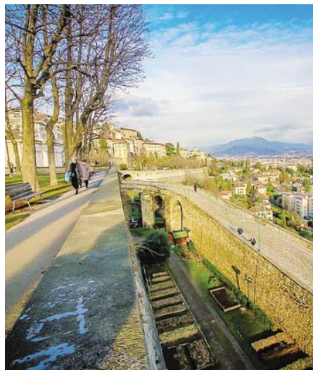
Il viadotto di San Giacomo dove si interverrà
