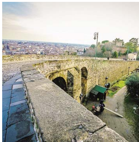
I parapetti che verranno rifatti
