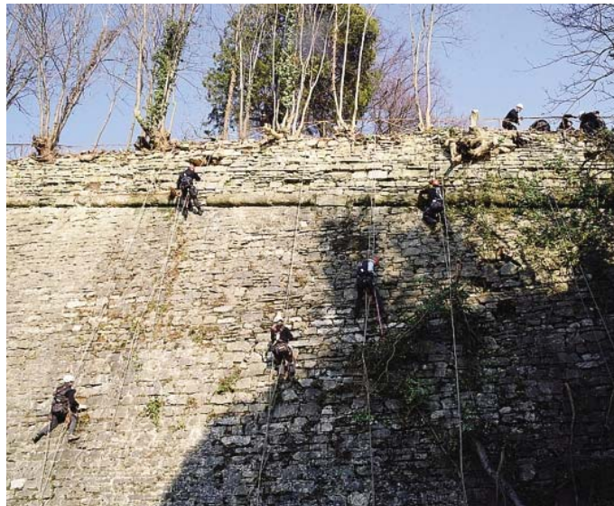
Sono stati 14 i rocciatori che hanno liberato da piante e sterpaglie il lato nord delle Mura FOTO BEDOLIS
