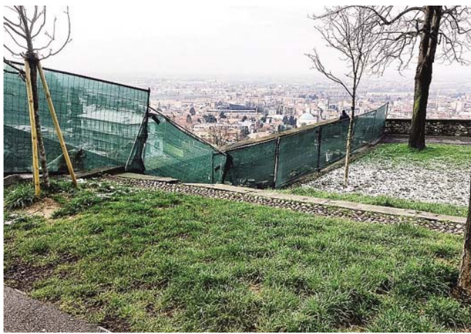
I lavori sulla piattaforma di Santa Grata per il rifacimento dei parapetti
