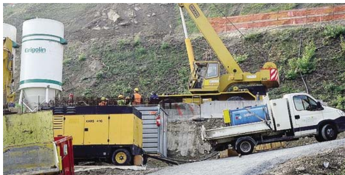
Il cantiere per il parcheggio alla Fara sotto l'ex faunistico
