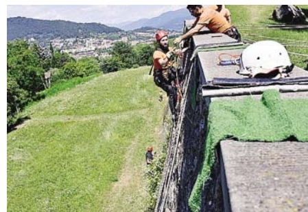
Lavori di pulizia, ieri, sul bastione di Porta San Lorenzo
