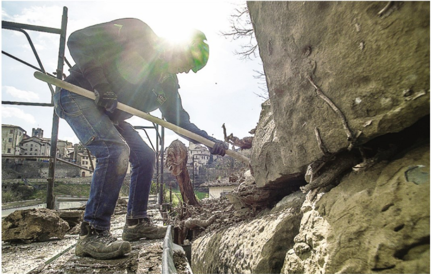
Muratori al lavoro sul baluardo di Valverde dove da pochi giorni si è concluso il cantiere per la pulizia e il restauro delle Mura BEDESCHI
